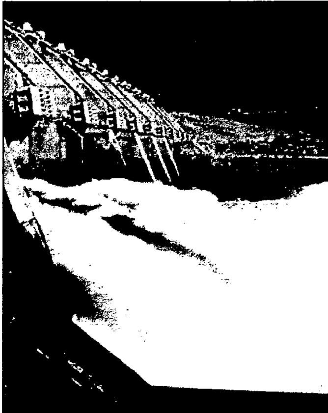
Fig. 3.1 Flujo de agua con alta velocidad saliendo de un vertedor
