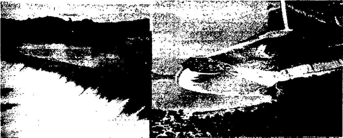
Figura 2.12 Vista del vertedor en abanico de la presa Sanalona, Oaxaca
