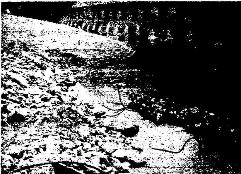
Figura 5.41. Daño en el labio de la cubeta disipadora de la Presa Las Alazanas
