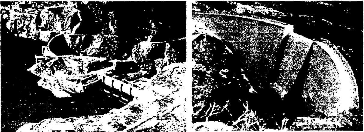
Figura 2.1 Cortinas tipo arco de concreto no vertedora y vertedora respectivamente.
