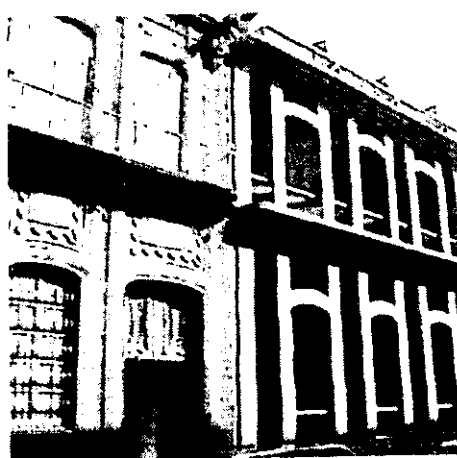
Intervención del Arq. Teodoro González de León 5
