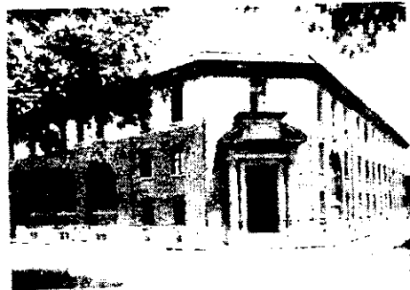
Fotografía #4: Mismo acceso (fotografía anterior) en su estado Original, 1911.
