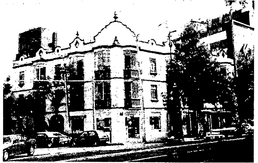
Huichapan 1 construido en 1928
