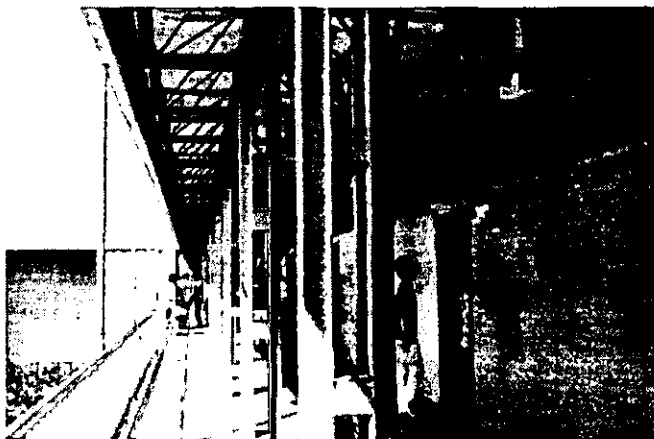
Fig. 70 Preparatoria Central, pasillo y aulas (AOV).
