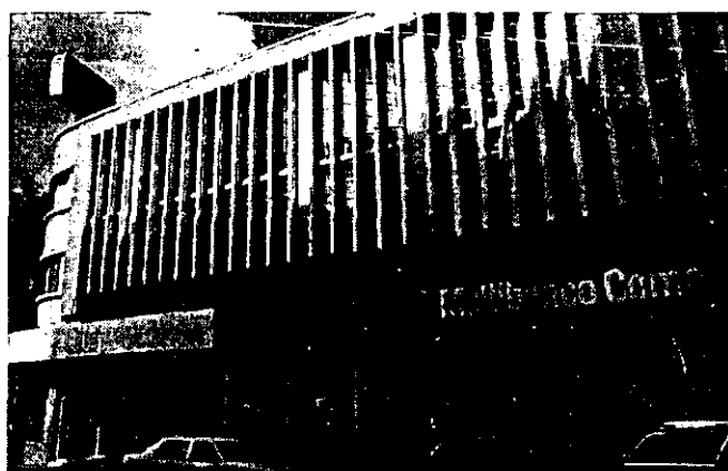
Fig. 49 Edificio Echavarría (AOV).
