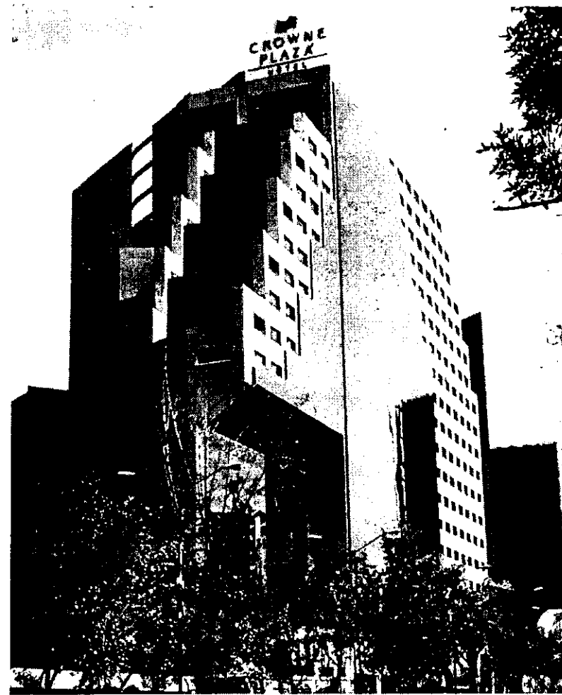
Fig. 191 Hotel Crown Plaza, en Paseo de la Reforma, ciudad de México (AOV).
