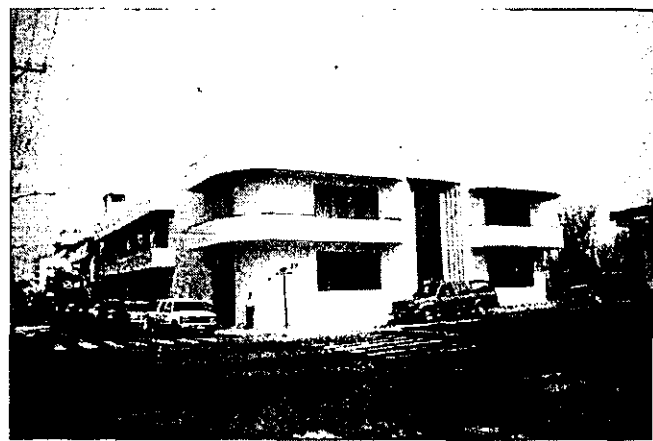
Fig. 113 Casino Culiacán, estado actual (AOV).
