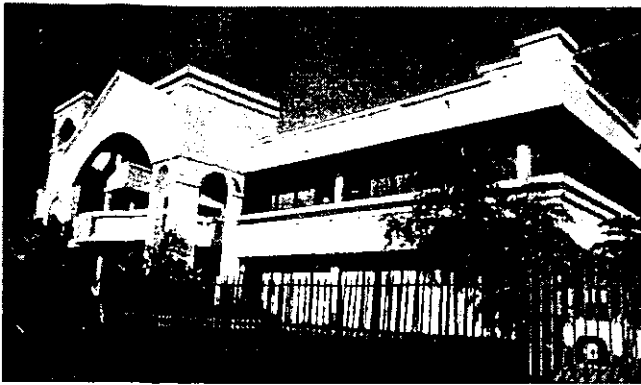
Fig. 218 Edificio de oficinas (AOV).
