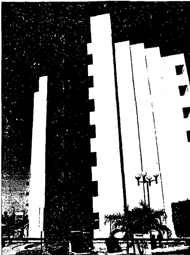
Fig. 168 Edificio de oficinas (AOV).
