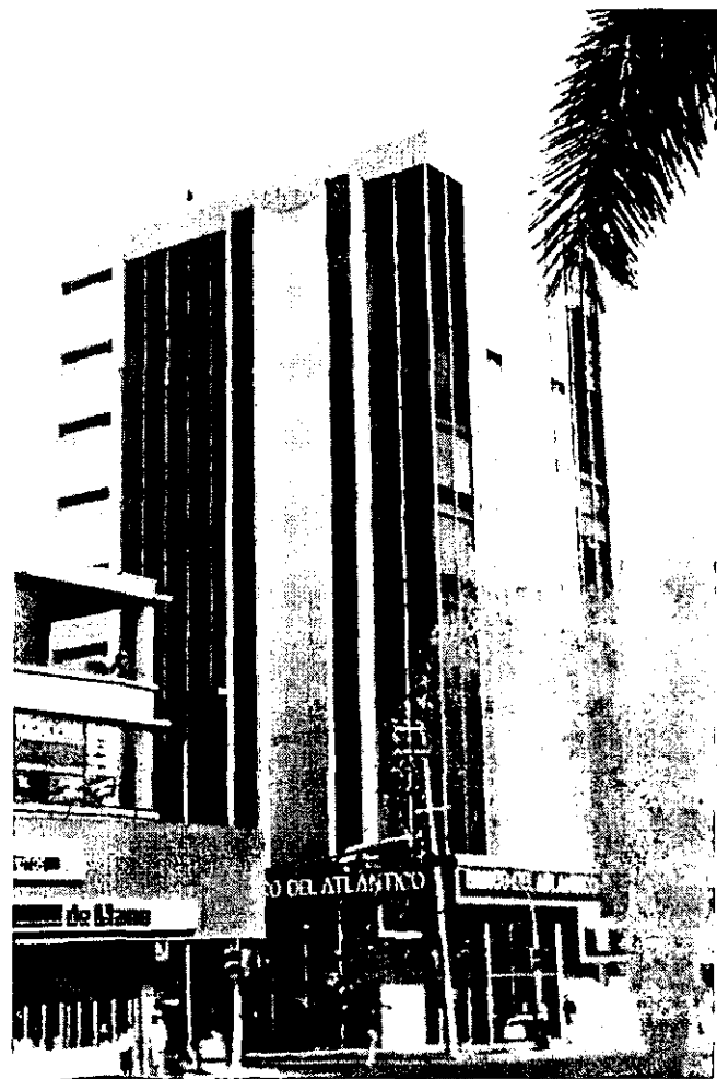
Fig. 150 Edificio del Atlántico (AOV).
