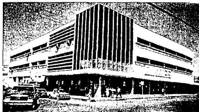
Fig. 50 Almacenes Zaragoza (AOV).
