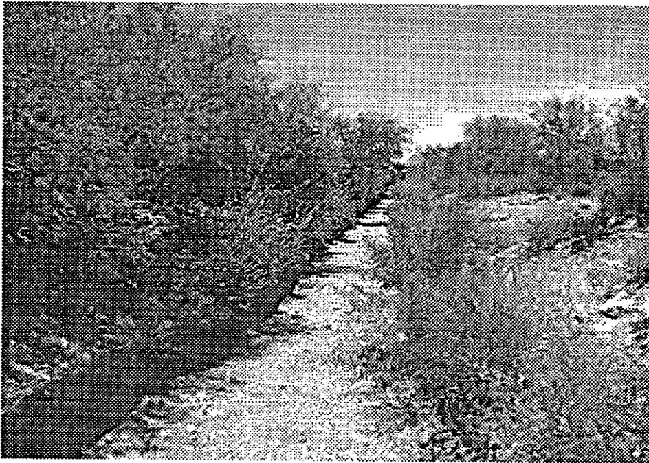
Foto: canal no revestido para la conducción de agua a las parcelas
