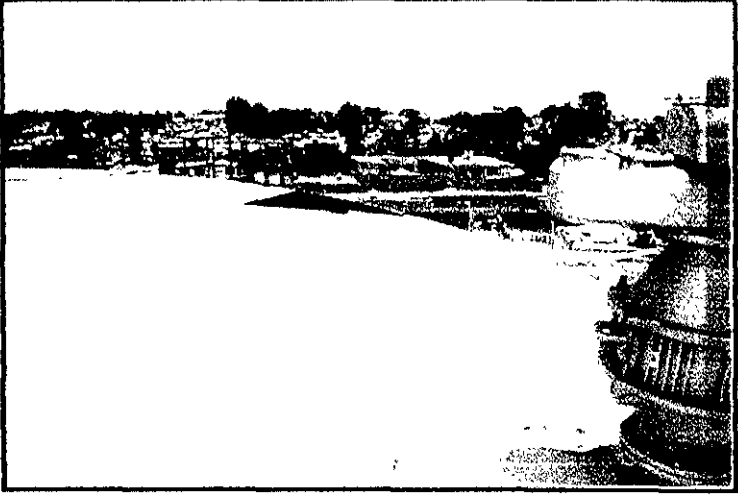
VISTA DEL TECHO DEL TANQUE.
