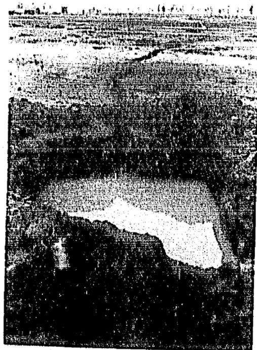
Fig. 13. Fotografía de una grieta localizada entre las pistas del Aero-puerto Central. El agua de lluvia inundó el pozo a cielo abierto excavado posteriormente a la formación de ella.
