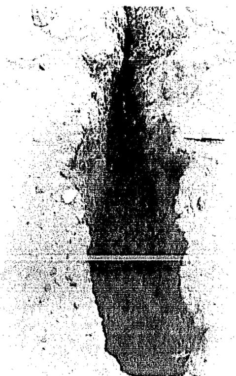
Fig. 14. Fotografía de cerca de una grieta entre las pistas del Aero-puerto Central que muestra derrumbes en las paredes de ella.
