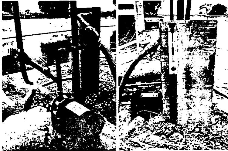
Figura 18. Bomba, válvulas y rotámetro
