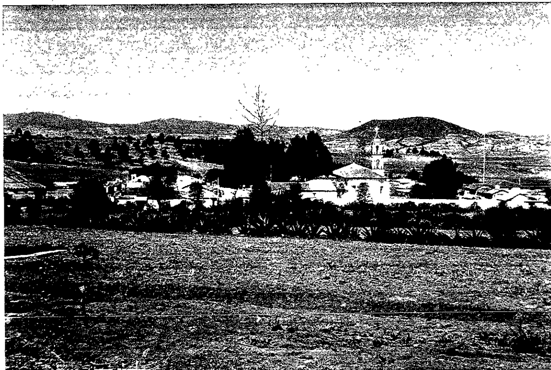
San Antonio Pueblo Nuevo, vista Norte.
