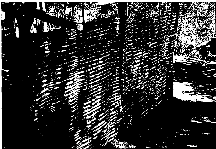
Gráfico 38. Paneles del muros de bahareque soportados por estantes, horcones y pie derecho, en la población de La Sidra municipio de Coquimatlan.
