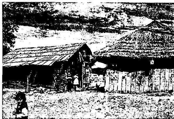
Gráficos 4 y 5. Vivienda de tejamanil y estructura de torito en la montaña (arriba); y esquema segmentado (abajo), ambas en El Terrero, municipio de Minatitlán.
