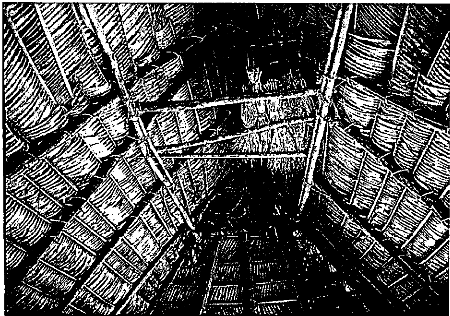
Gráfico 45. Cubierta de palpa con estructura de mono en la población de Ticuz.
