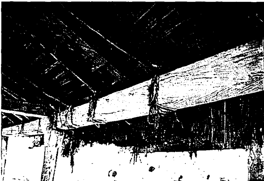
Gráfico 22. Marcos de madera constituidos por horcones y soleras, en la comunidad de Miscuate Comala.
