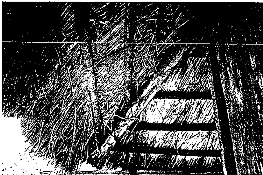
Gráfico 32. Volado para proteger radiación solar, lluvia y los escurrimientos de agua en El Terrero, municipio de Minatitlán.
