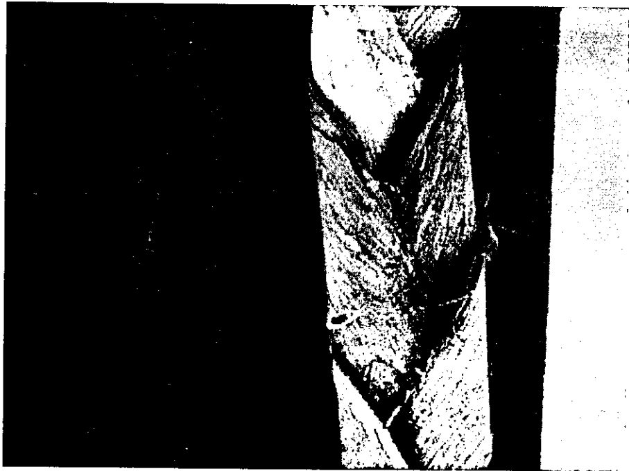
Gráficos 55 y 56. Amarres entre horcones y puntales en la estructura de la Petatera; Trenzado de zacate en una casa de Ixtlahuacán (abajo)
