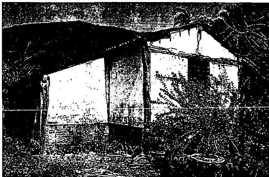
Gráfico 38. Estructuras de apoyo mixtas, con muros de carga y marcos de madera en la población de Alcosahue, Ixtlahuacán.
