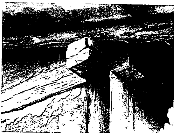
Gráfico 63 y 64. Ensamble de pilar, solera y cadena cuartonados en Jalisco; Empotramiento de una cadena al muro de adobe en una morada de la ciudad de Colima (abajo).
