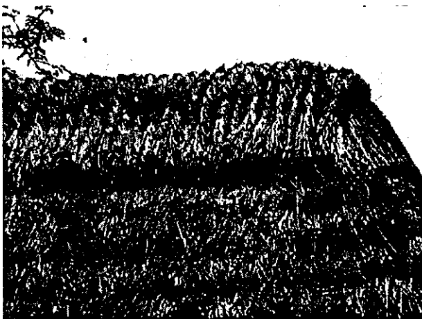
Gráfico 50. Trenzado de manojos de zacate en la cumbreira para cerrar y unir las dos caídas o aguas principales de la cubierta, en una vivienda de Ixtlahuacán.
