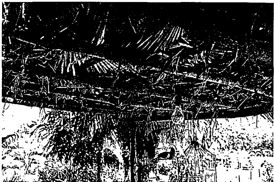
Gráfico 24. Modelo de una ramada constituida por una cubiertas con estructura horizontal bidimensional.
