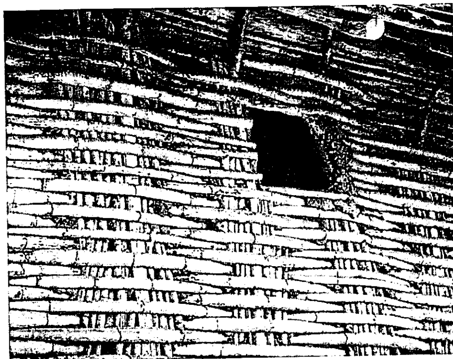
Gráfico 30. Muro de bahareque con un vano amanera de ventana.
