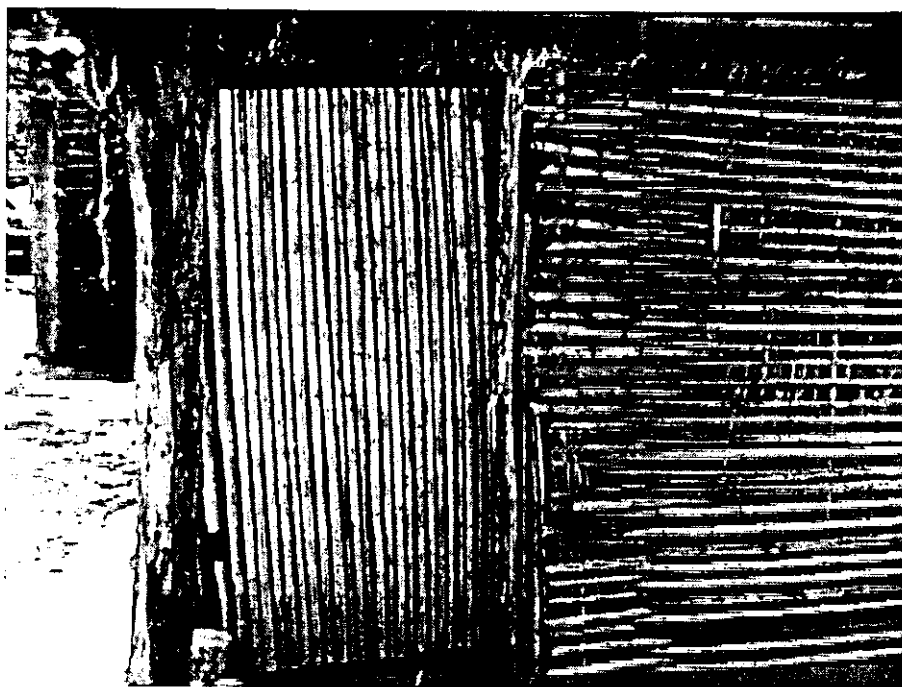
Gráfico 44. Puerta de otate amarrado a un marco de latillas, en el pueblo de Ixtlahuacán.
