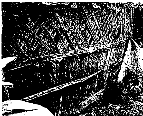
Gráfico 66. Fajillas clavadas a un muro de tejamanil, en la comunidad de El Naranjal municipio de Cuahutemoc.
