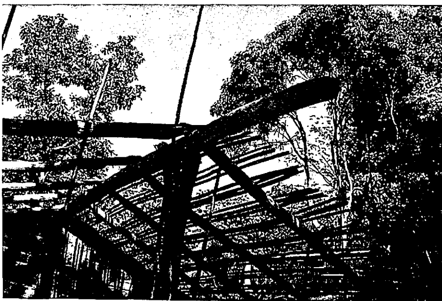
Gráfico 28. Caballete sobre Pie derecho u horcón caballetero, en la comunidad de La Sidra municipio de Coquimatlán..
