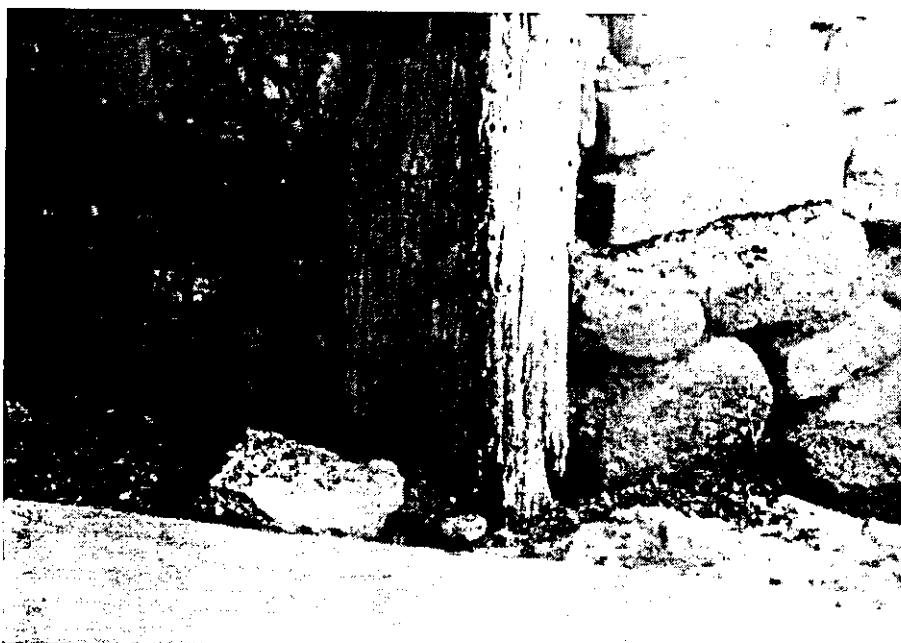
Gráfico 57. Morteros de cal y arena para pegar ladrillo y piedra o hincar los apoyos de madera, en Ixtlahuacán.
