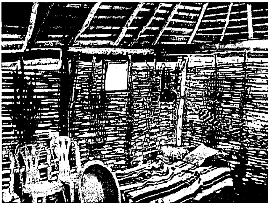
Gráfico 29. Muros de bahareque que facilitan el flujo de ventilación evitando la acumulación de humedad al interior de la morada, casa ubicada en Los Ortices, municipio de Ixtlahuacán.
