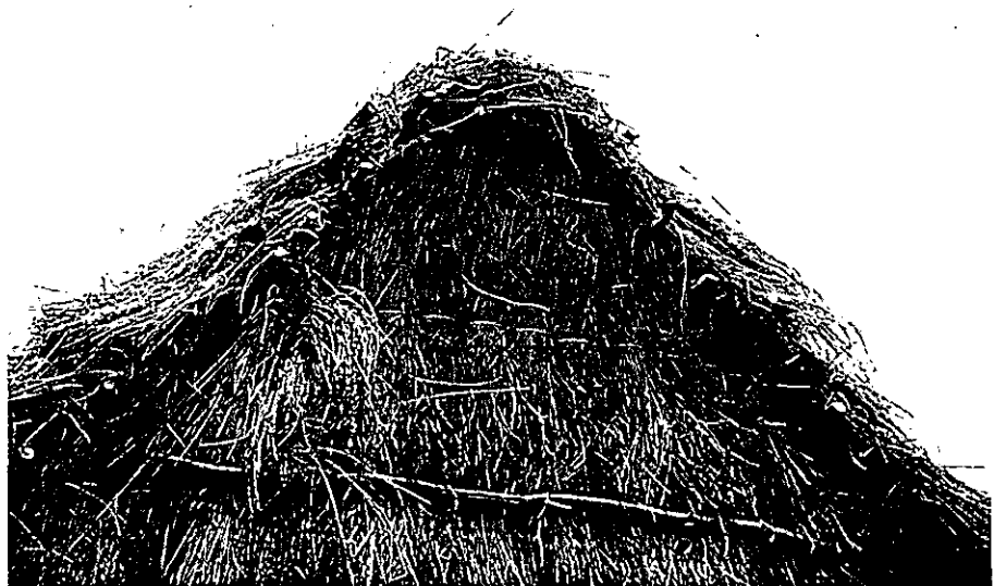
Gráfico 24. Culata de zacate en una construcción con estructura de torito, en Carrizalillos, Comala.
