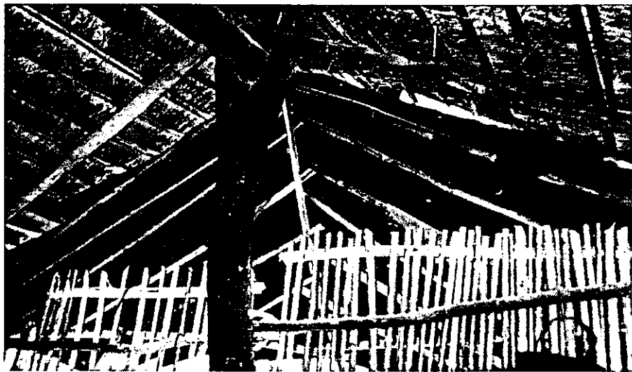
Gráfico 30. Pie derecho interior en una casa con estructura de torito y cubierta de zacate, en la comunidad de Campos 4.
