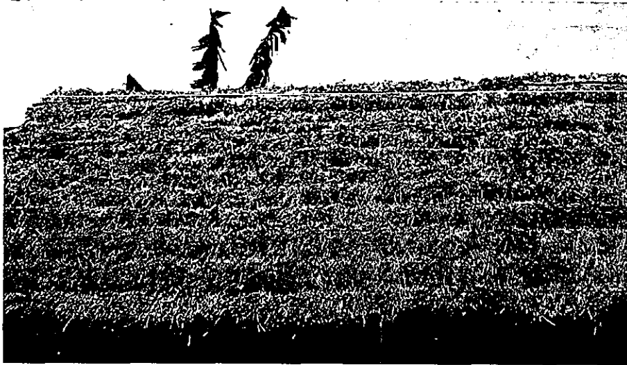
Gráfico 60, 61 y 62 Tendidos empalmados de zacate en San Gabriel; Tabletillas de tejamanil traslapadas, en Cofradía de Suchitlan y empalmado de soleras cuartonadas en Villa de Álvarez.
