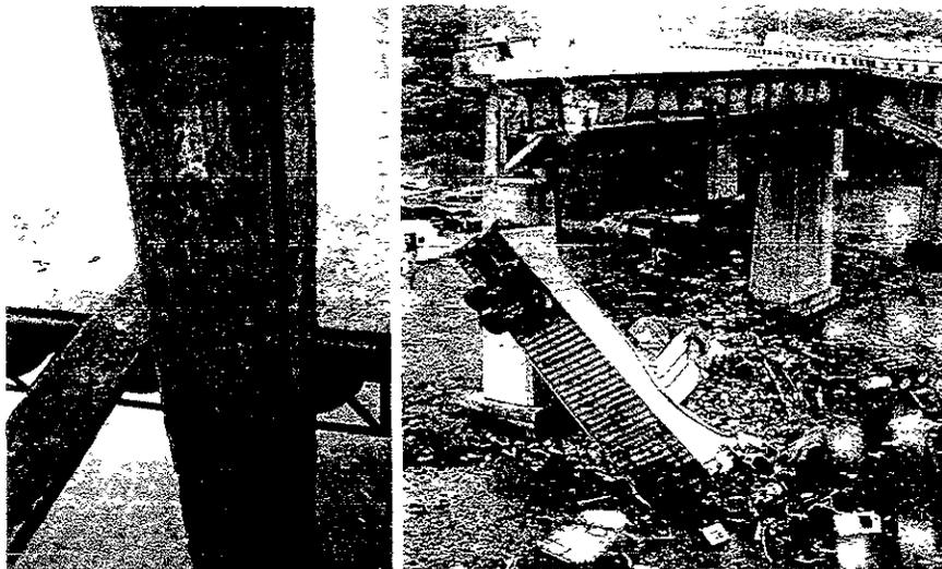
Figura 1.1.1. Principios y falla de un puente debida a corrosión<sup>(8)</sup>.
