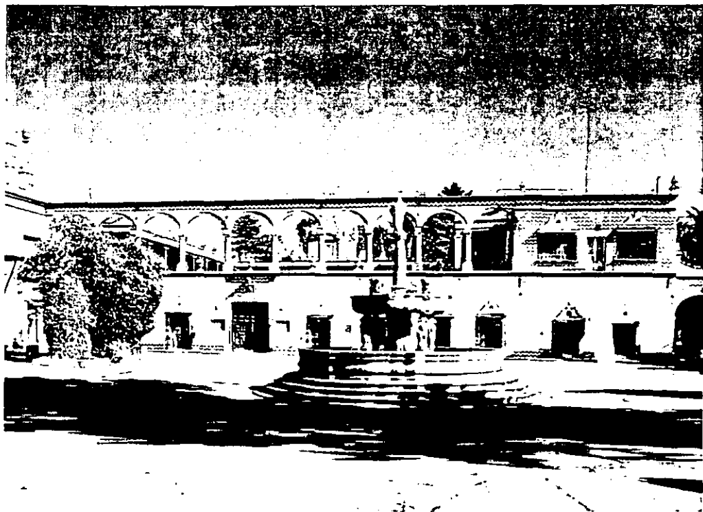
Vista actual de la plaza principal desde la iglesia hacia la fachada de la casa, año 2001.
