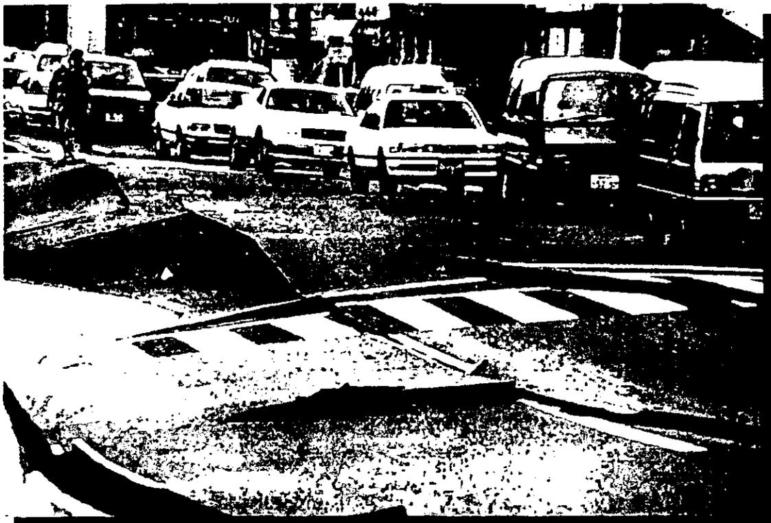
**Fig.1.12** Fractura de pavimentos en Kobe, Japón, 1995. La licuación del suelo provocó que las capas superficiales oscilaran generando fracturas.
