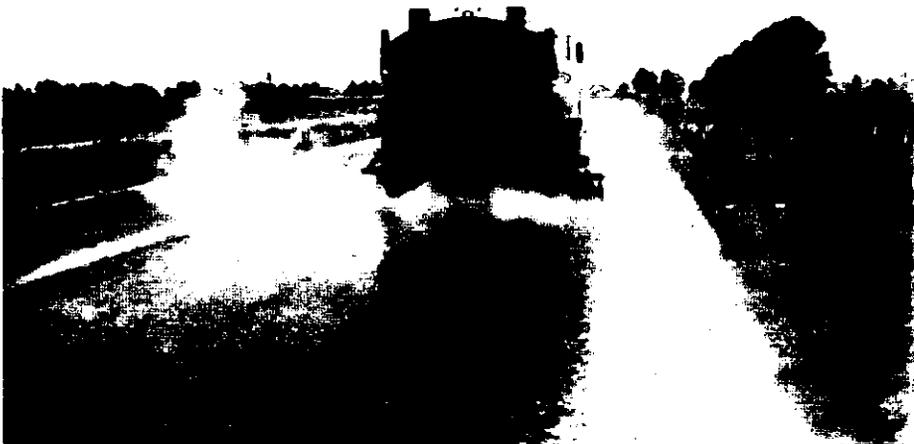
*Fig.1.5. Aplicacion del riego de impregnación con petrolizadora, utilizando emulsión asfáltica RM-2K*
