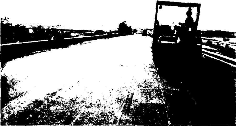
*Fig.V.9. El compactador tandem realiza el primer armado de la carpeta de concreto asfáltico.*
