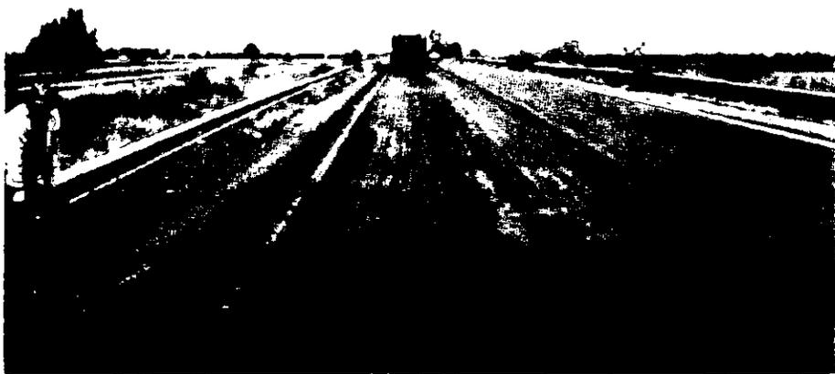
*Fig.V.6. Aplicación del riego de liga, con emulsión asfáltica RR-2K*
