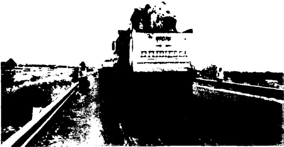
*Fig.V.7. Se manta el riego de liga con material de carpeta asfáltica*
