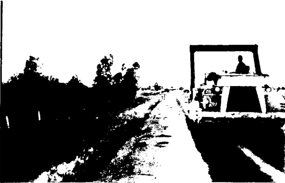
*Fig.V.4. Se lleva acabo el proceso de compactación en la capa de base estabilizada.*
