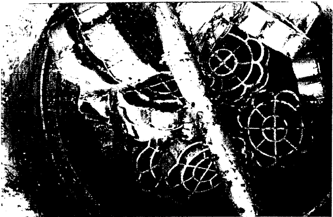
Figura A2 Tubería de alimentación al reactor.
