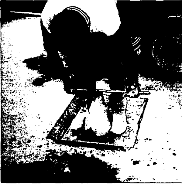
FIGURA 5.6 SE ENRASA EL CONCRETO MEDIANTE EL MOVIMIENTO DE RODAMIENTO DE LA VARILLA.
