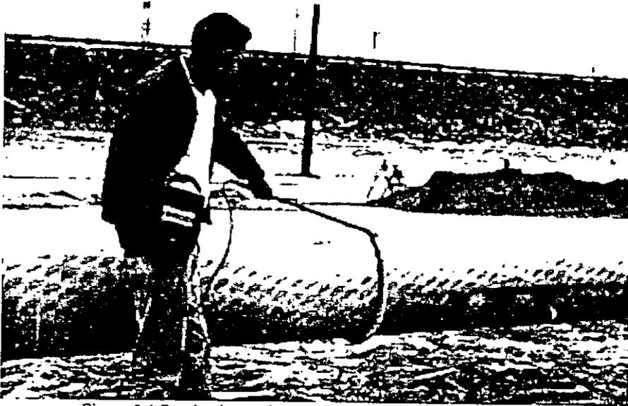
Figura 3.1 Prueba de continuidad del recubrimiento anticorrosivo.
