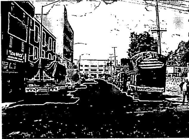
Vista calle Puente de Santo Tomás desde la calle Roldán, 1999,
