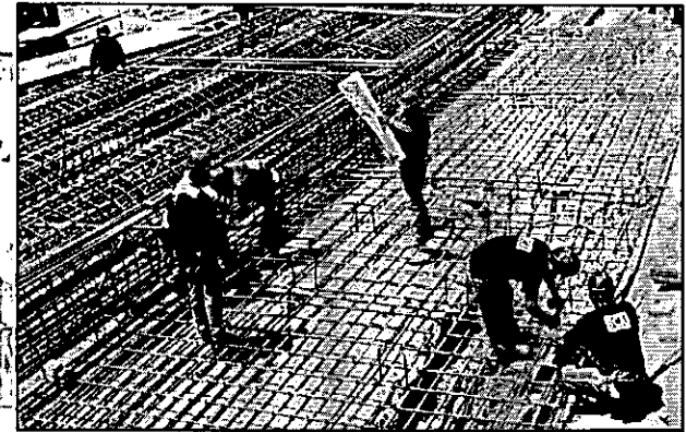
Armado de muro Milán, Fuente: Ingenieros Civiles Asociados, 1998
