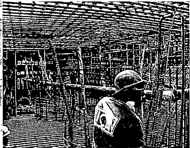
Armado de losa de cimentación colocada sobre lastre, Fuente: Torre Mayor, Ingenieros Civiles Asociados, 1999
