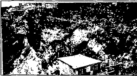
Fotos 13 y 17, Socavación en taludes por escurrimientos superficiales, Colonia, Circuito Siete Sabios.
