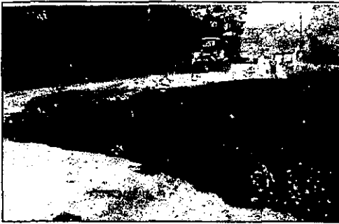
Fotos 18 y 20, Fallas en el cuerpo de terraplén de la carretera que va ha Aire libre.
