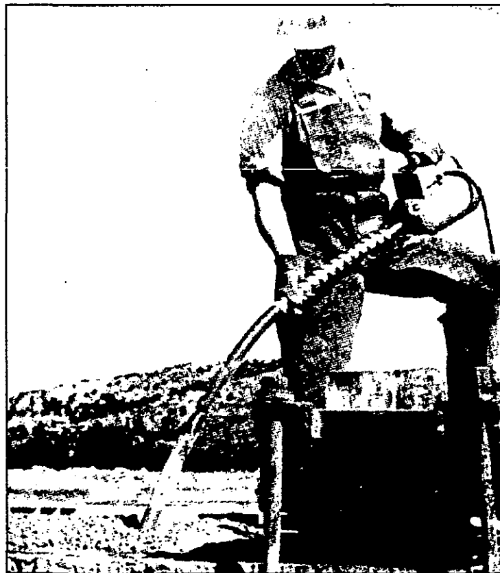
Figura 4.4.1 Vibración del concreto.
