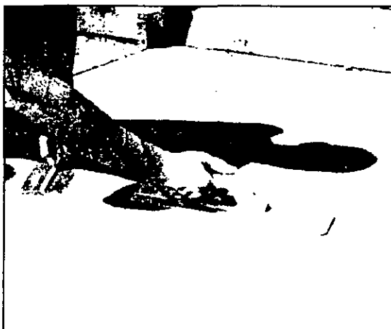
Figura 4.5.2 Emparejado manual izquierda, emparejado mecánico derecha.
