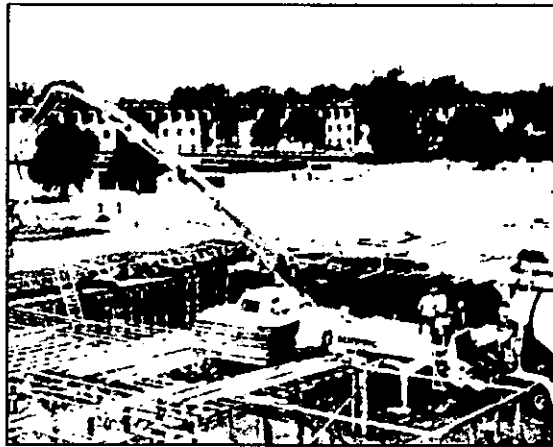
Figura 4.3.9 Bomba y pluma montada sobre un camión.
