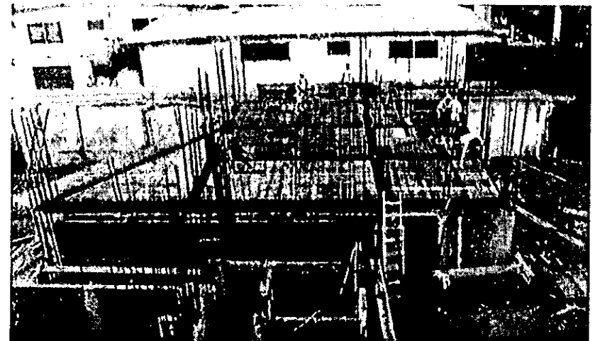
VISTA GENERAL DEL CIMBRADO EN TORRE TRES, QUE RECIBE EL ARMADO DE LOSA DE ENTREPISO.
