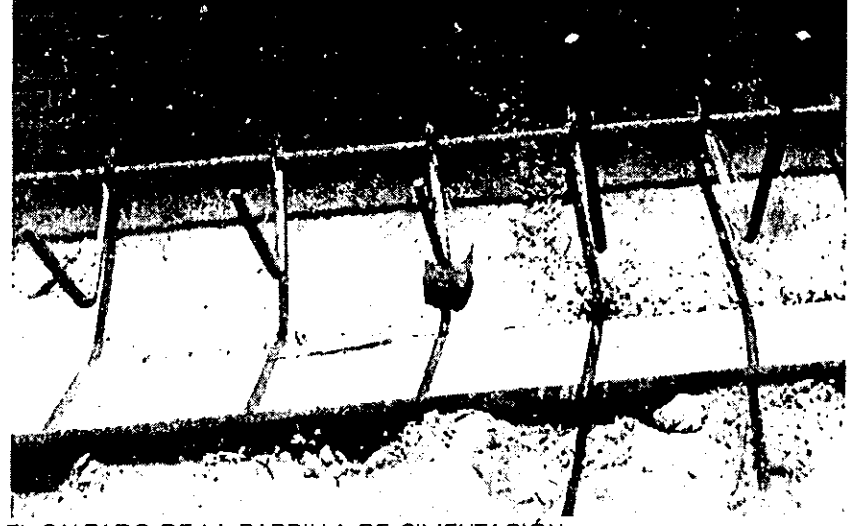
UTILIZACIÓN DE "POYOS" REALIZADOS EN OBRA PARA EL CALZADO DE LA PARRILLA DE CIMENTACIÓN.
