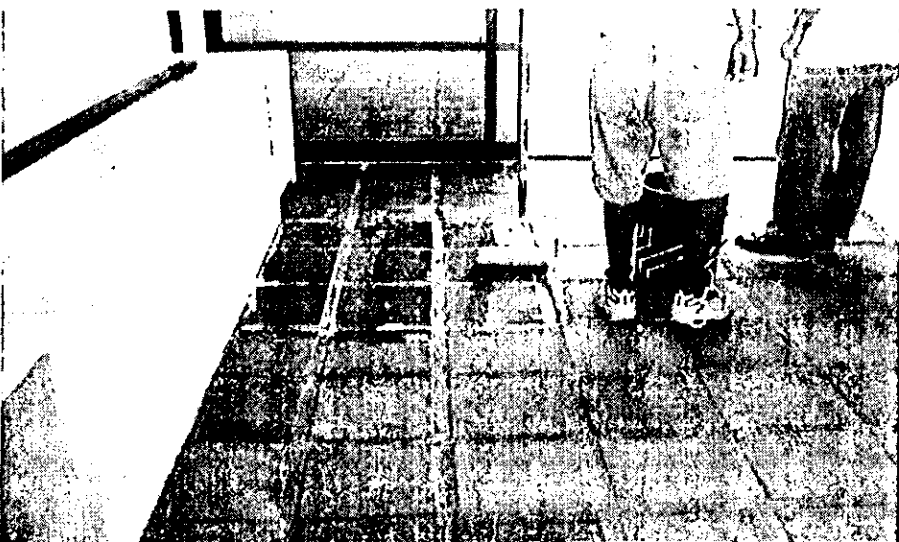
APLICACIÓN DE FESTERBOND COMO SELLADOR EN PISO DE BARRO.
