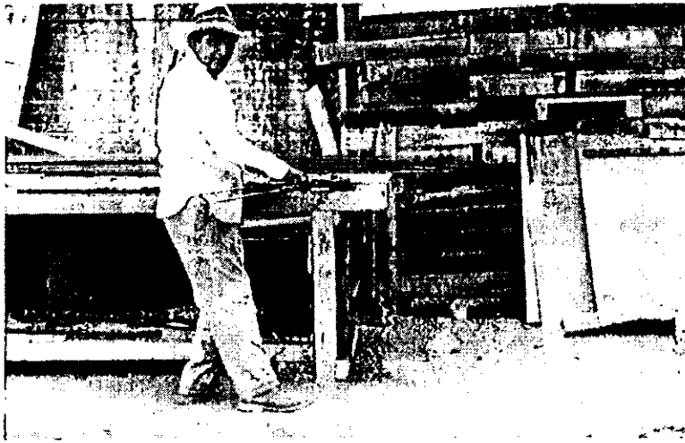
BANCO DE MADERA HECHO PARA EL HABILITADO DE ACERO.
