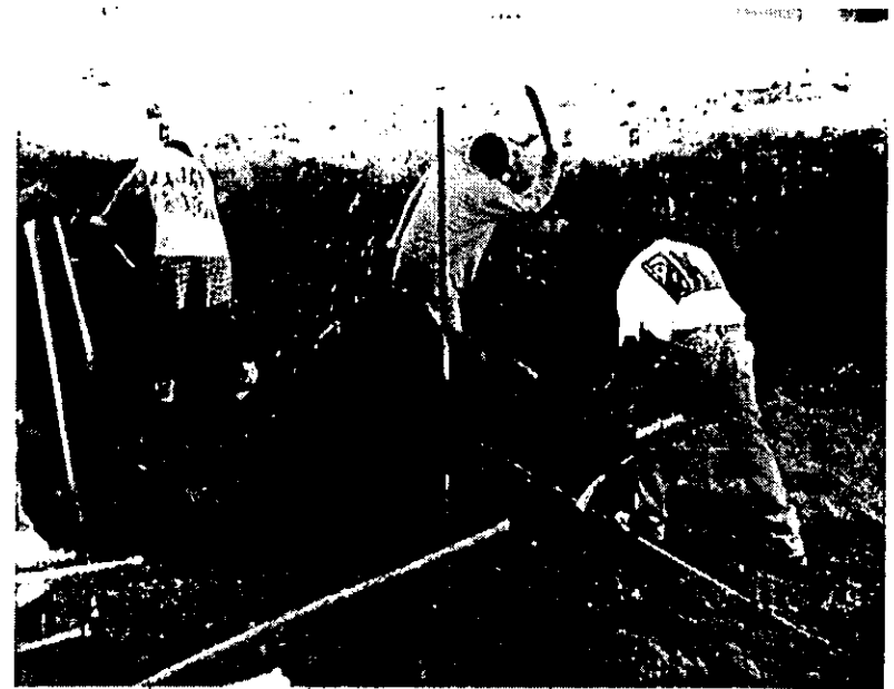
NIVELACIÓN DEL CAJÓN DE CIMENTACIÓN EN TORRE DOS.
