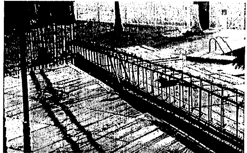
COLOCACIÓN DE DALAS DE CERRAMIENTO EN TORRE TRES.
