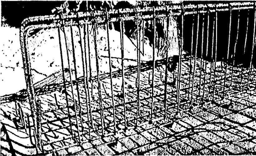
ARMADO DE CIMENTACIÓN DE ACUERDO AL CÁLCULO EN TORRE DOS, EN EJE 12.
