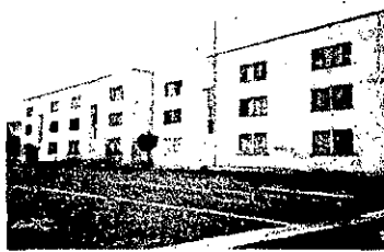
4. Contraesquina Surponiente FFCC de Cintura y E. Zapata
