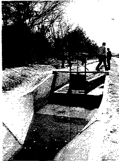
Foto 4.10 Caída aguas abajo del vertedor
