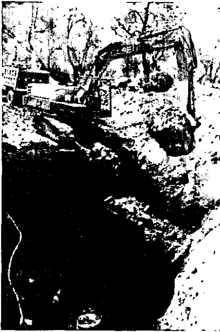
Excavaciones para fosos de muros de contención.
