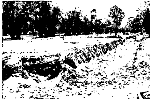
Área destinada para la construcción del Exhibidor de Mariposas. Se pueden apreciar las cepas de los antiguos fosos de los albergues demolidos.
