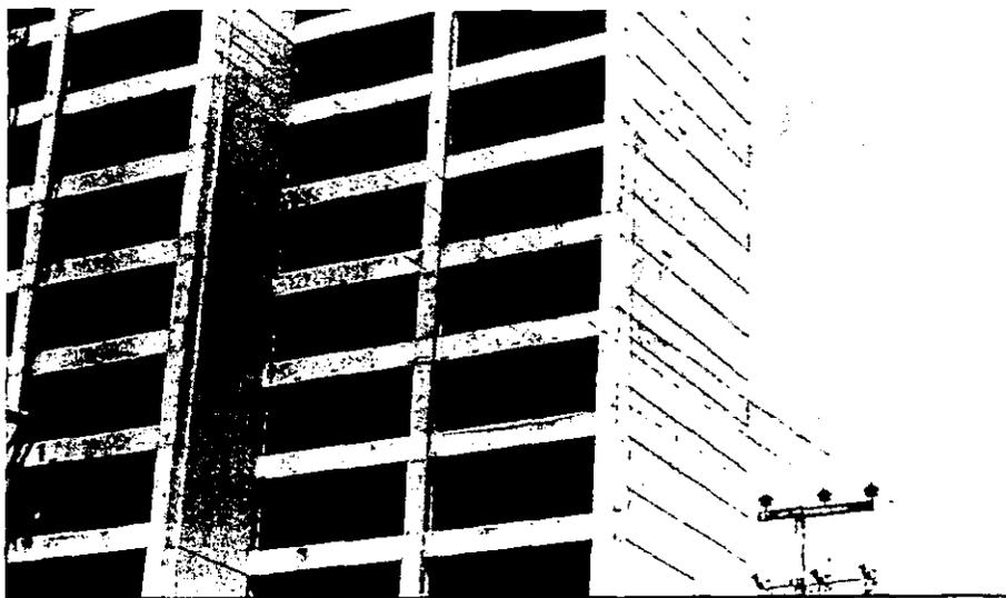
*Fig. 2.2 Losa maciza de concreto reforzado como sistema de piso*
