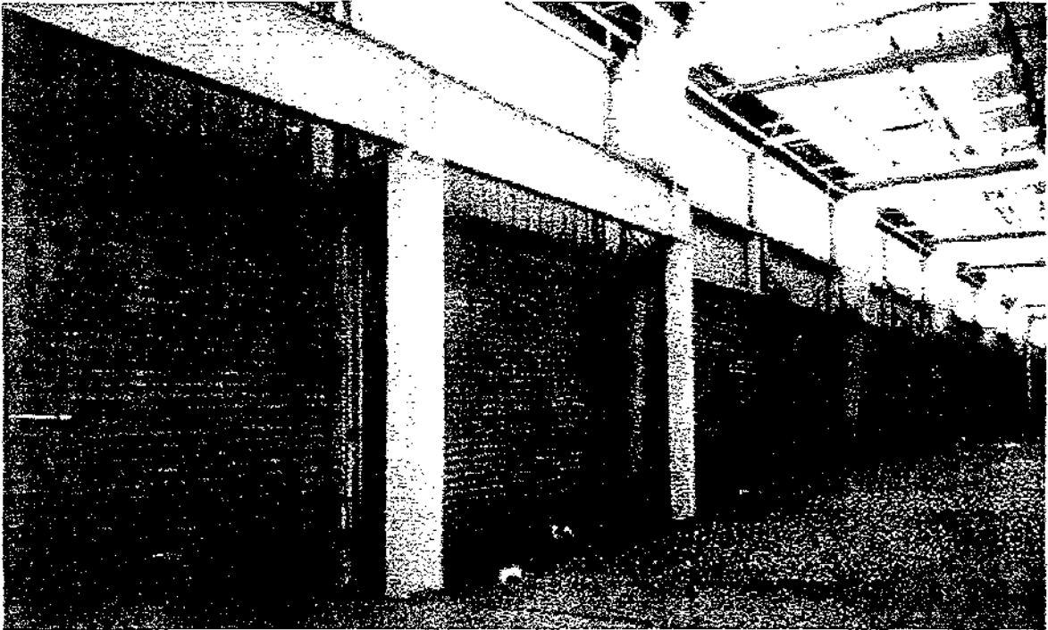
Figura 18. Interior de las bodegas.
