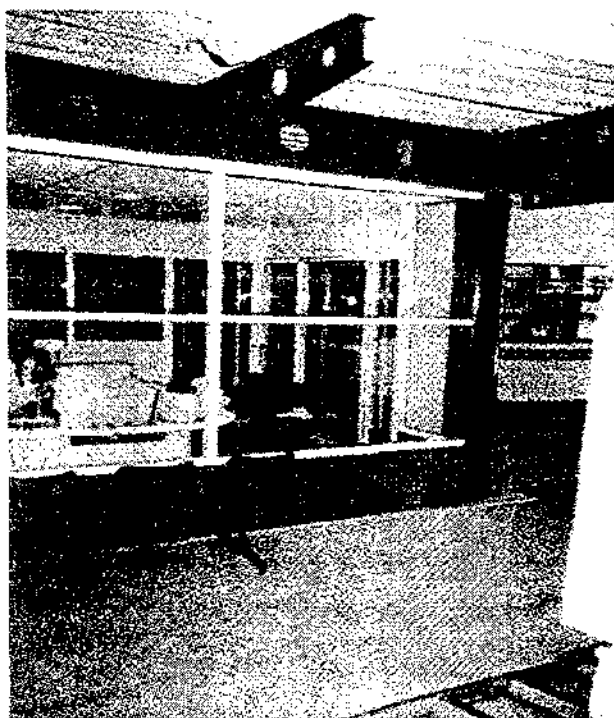
Figura 22. Oficinas de administración y control.
