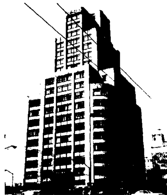
III-15 Edificio La Mariscala, 1970
