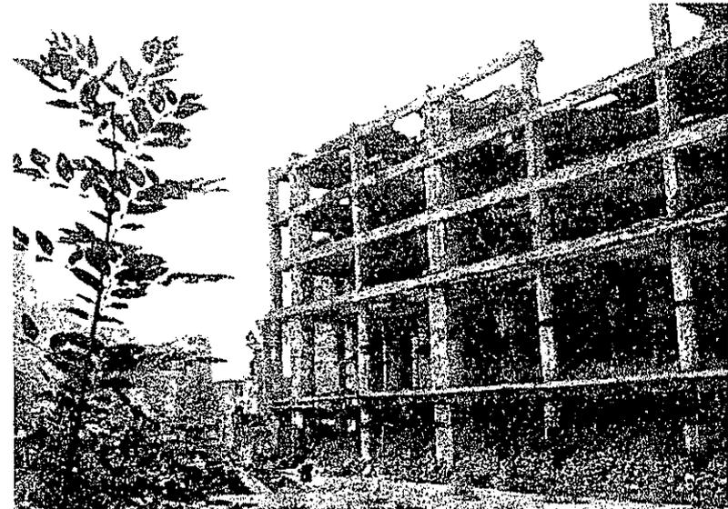
e) Desprendimiento y desmoronamiento del concreto de las columnas, así como pandeo del acero de refuerzo, como consecuencia de la repetida inversión de esfuerzos y las grandes deformaciones provocadas por el sismo. En algunos casos el confinamiento proporcionado por el esfuerzo transversal no era adecuado.
