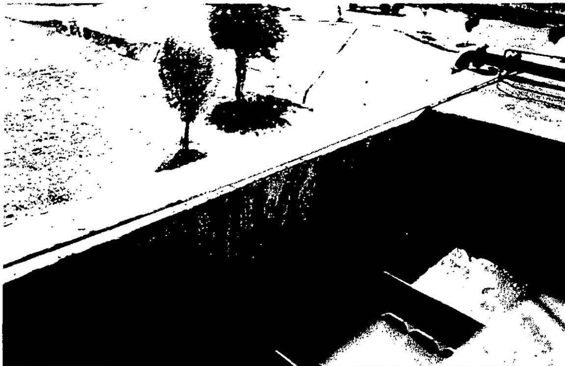
Figura 5.21 Problemas de corrosión en la parte superior del reactor. Módulo Norte
