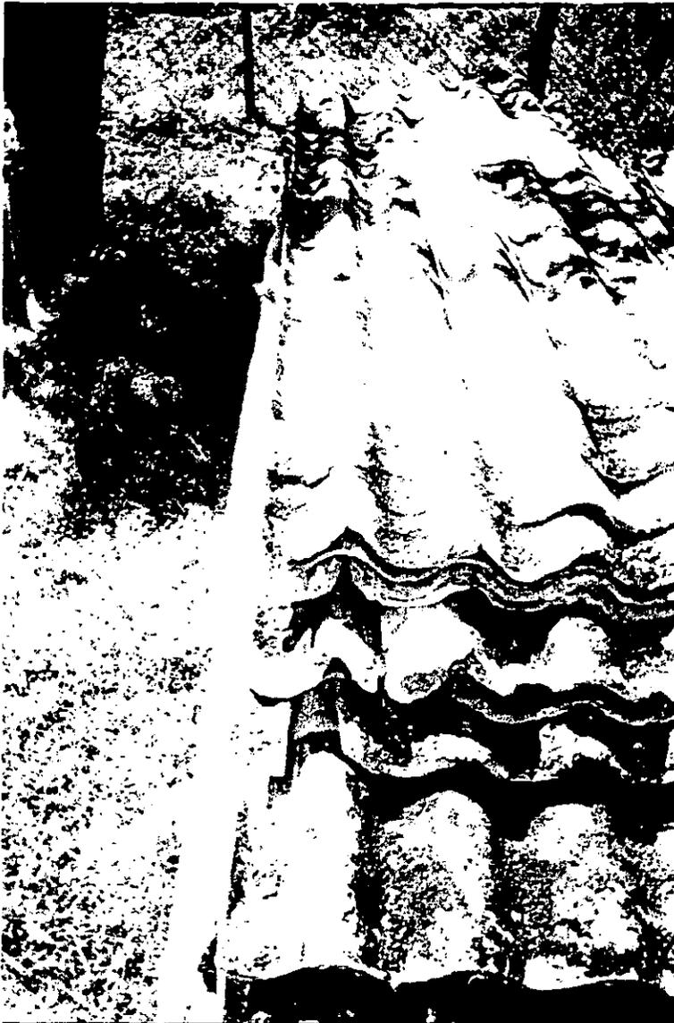
Figura 5.20 Mamparas de asbesto cemento dañadas. Módulo Sur
