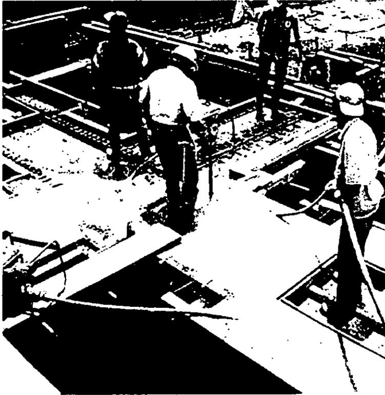
Figura 3.16 Compactación del concreto mediante vibración
