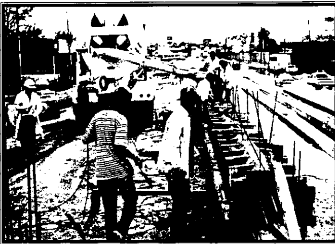
Figura IV. 16. b. Colado de guarnición
