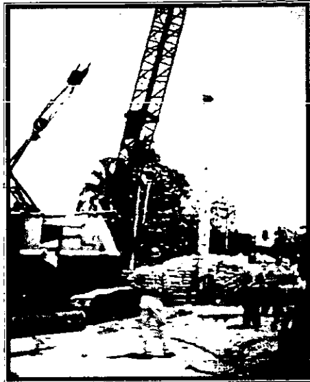
Fotografía 15. Introducción del primer tramo de pilote.
