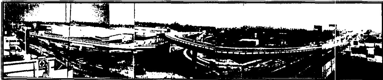
Fotografía 65. Vista general a la terminación de la superestructura.
