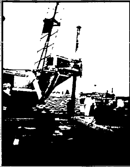
Fotografía 14. Vista de la perforadora al momento de la introducción del barreno para la perforación previa al hincado.
