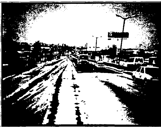
Fotografía 8. Vista de lo que será la Rampa de Salida Minatitlán Cuerpo A.
