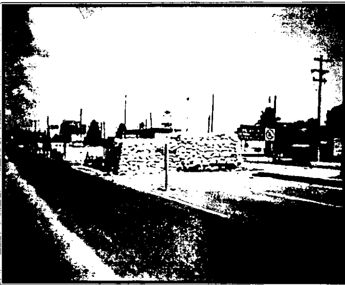
Fotografía 11. Aplicación de la precarga en la Rampa de Acceso Villahermosa Cuerpo B.
