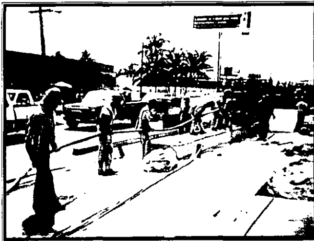
Fotografía 21. Introducción del acero de presfuerzo (torones) en los ductos de la trabe.
