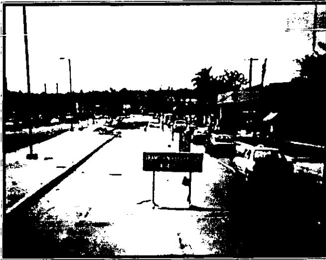
Fotografía 7. Vista de lo que será la Rampa de Acceso Villahermosa Cuerpo A.
