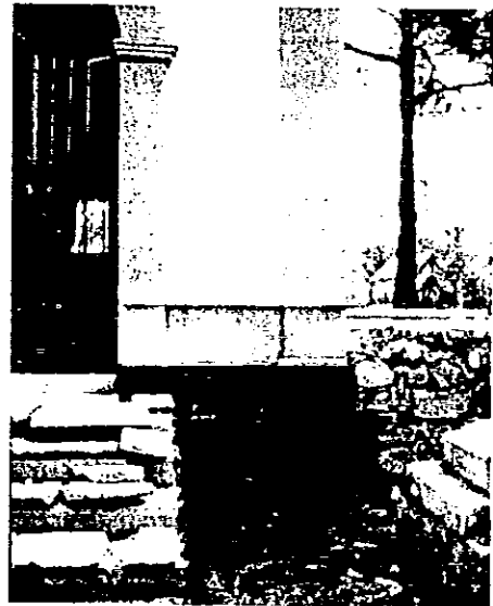
Restauración de escalones y elementos de recinto en la fachada principal del osario. Se aprecia un detalle de pasta que imita el recinto.
