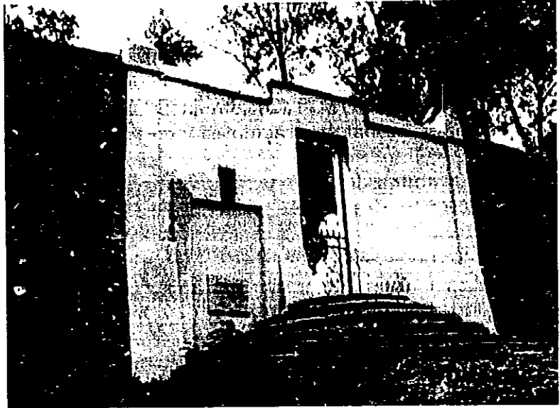
Vestigio de una de las puertas laterales (oriente) que daban a la rampa de vehiculos de subida al cementerio. La puerta que se encuentra abierta actualmente data de los años setenta (Archivo s. segarra. 1995)
