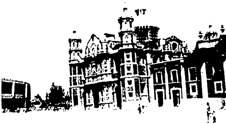
Situación actual del Santuario (se aprecia el desplome de la basílica antigua).
