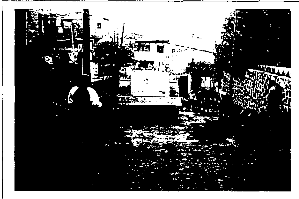
EN LA FOTOGRAFIA SE OBSERVA LA COMPACTACION DE LA SUB-BASE
