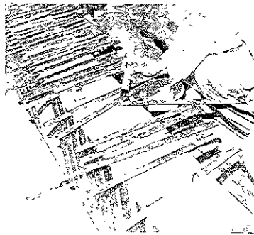
b) Limpieza del refuerzo externo
