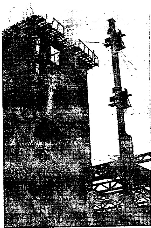
Figura 4.5.11 Estructura de acero en condiciones de integridad estructural
