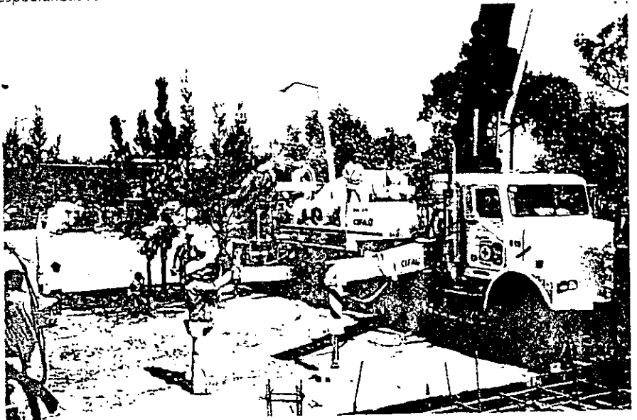
Figura 3.7.8 Colocación de carro bomba
