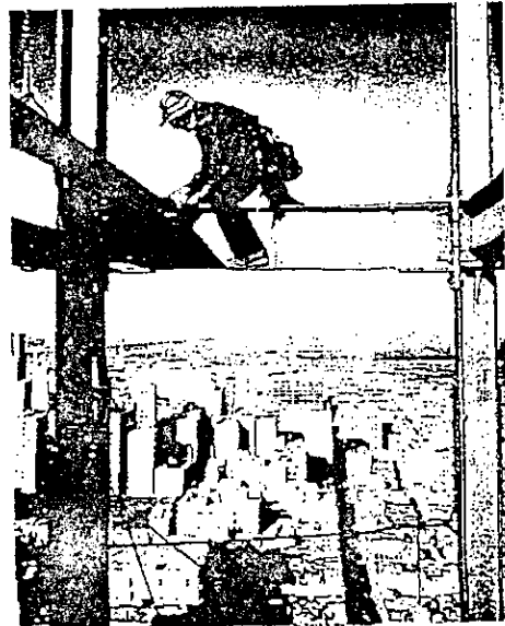
Figura 4.4.1 Montaje de estructura metálica
