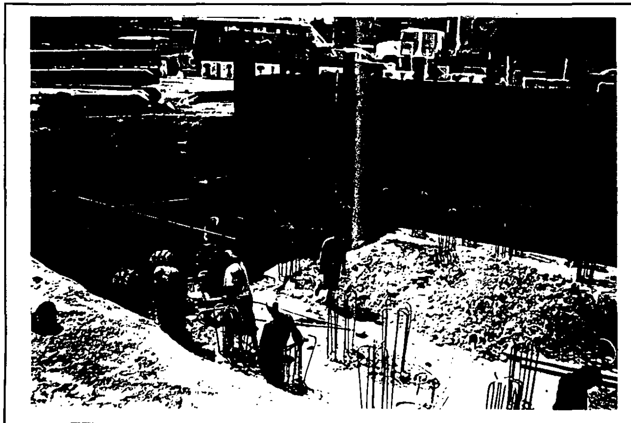
TRABAJOS DE DESCABECE DE PILOTES EN LA ZAPATA Z-35A EN LA AV. OCEANIA, TRAMO PARALELO A LA LINEA B DEL METRO
