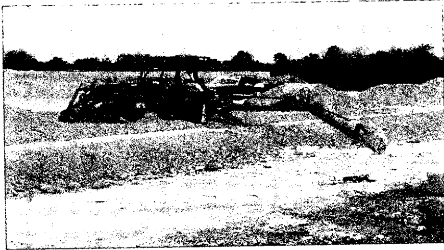
Excavación con equipo mecánico
