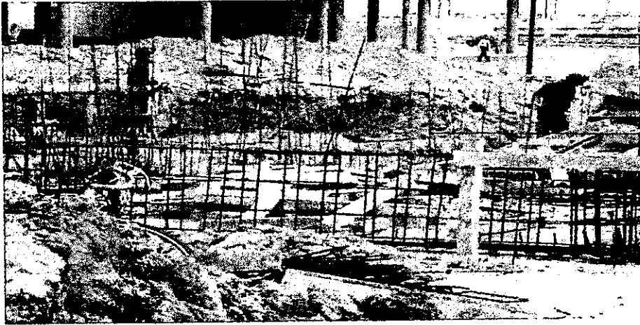
Armado de acero
