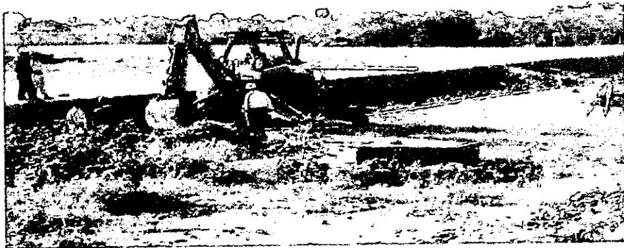
Excavación con brazo mecánico
