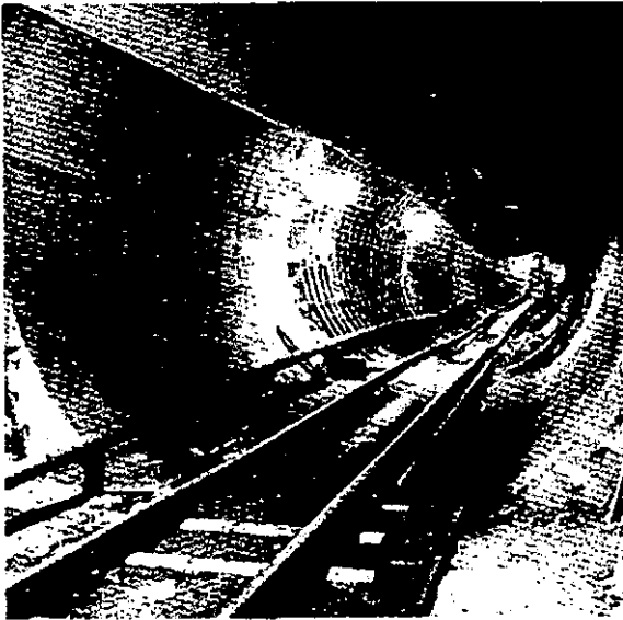
Figura 2.13 Túnel excavado con el Topo
