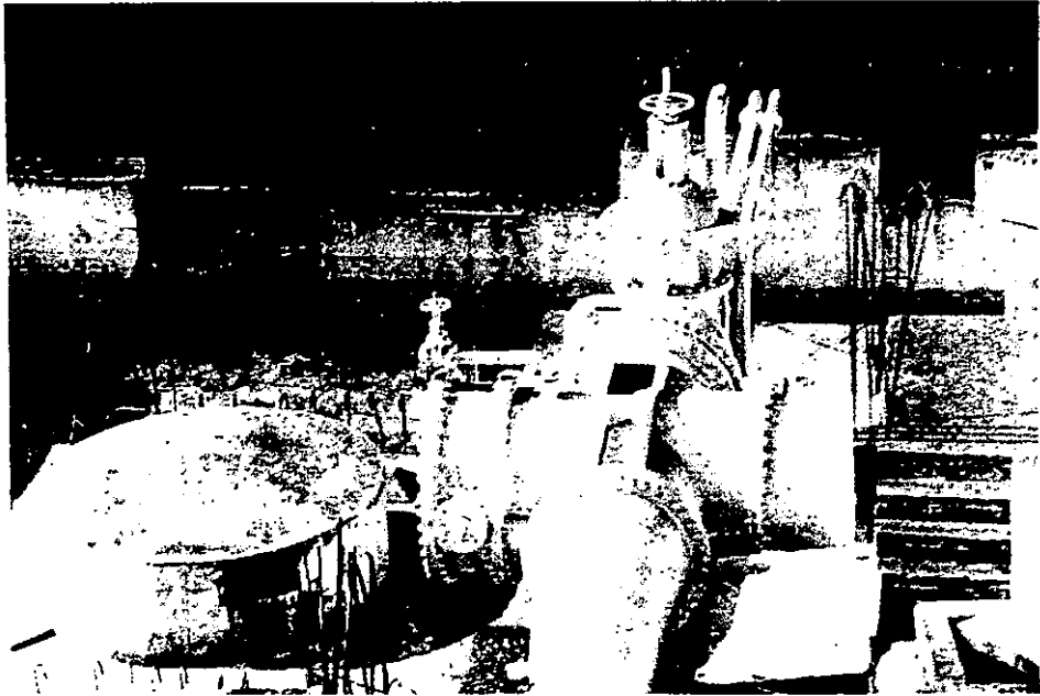
Foto 6. Subestructura de casa de máquinas. Caída "El Borracho".
