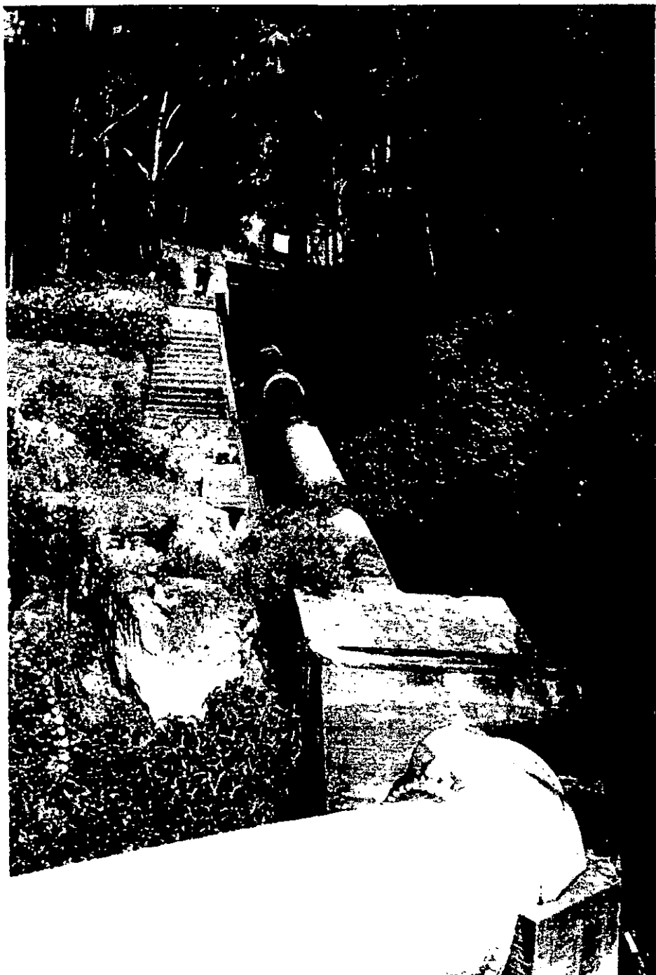
Foto 11. Altura disponible y tubería de presión. Caída "San Joaquín".
