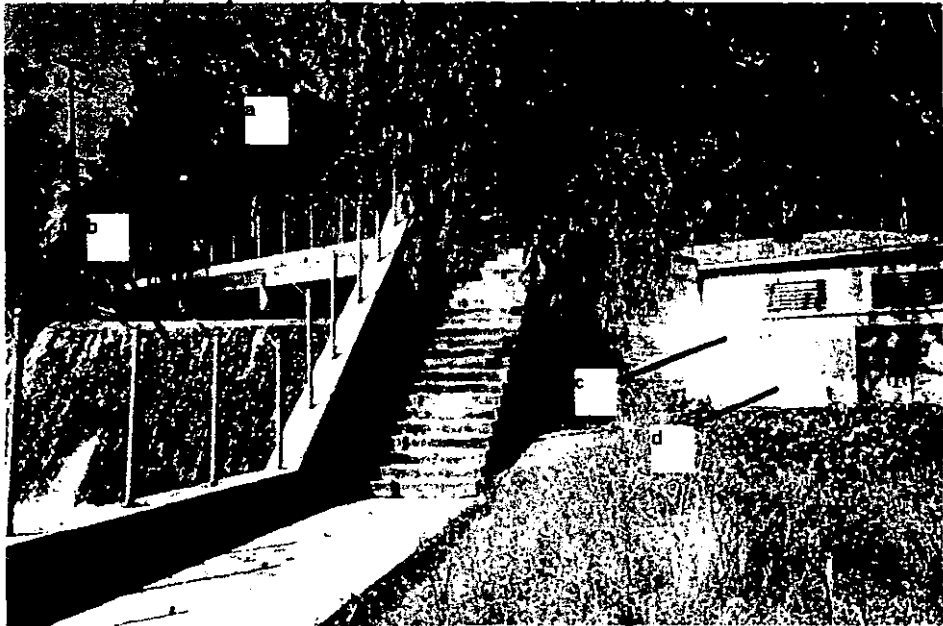
Foto 4 a)Tanque de almacenamiento, b)by-pass, c)caseta de válvulas, d)principio de tubería.
