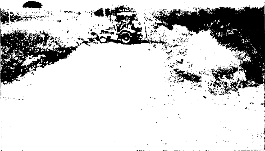
Figura IV.4.1.-Construcción del acceso a la torre No.18 localizada en el Km 7+350
