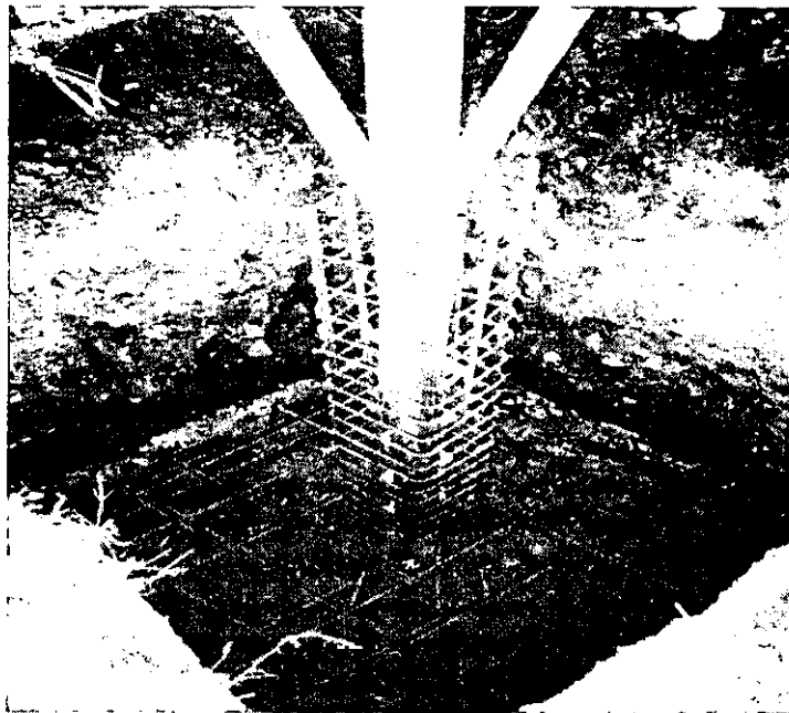
Figura IV:6.1. Armado de la zapata y del dado para colar monolíticamente la cimentación de la torre No.16 en el Km 6+375. Obsérvese la colocación del Stub y la Pata ahogados dentro del dado.
