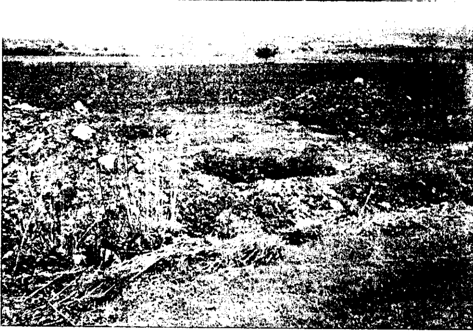
Figura IV.5.1.- Excavación manual para la cimentación de las torres
