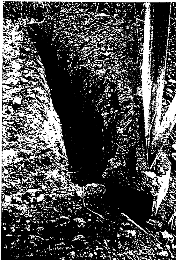
Figura IV.3.1.- Excavación de la zanja en la pata de la torre No. 4 para alojar el cable de tierra.
