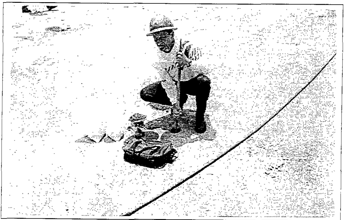
Foto 2 Pruebas de compactación
