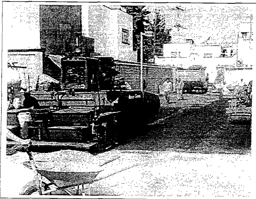
Fotos 32 y 33 Asfaltado y aplanado de patios para accesos estacionamiento
