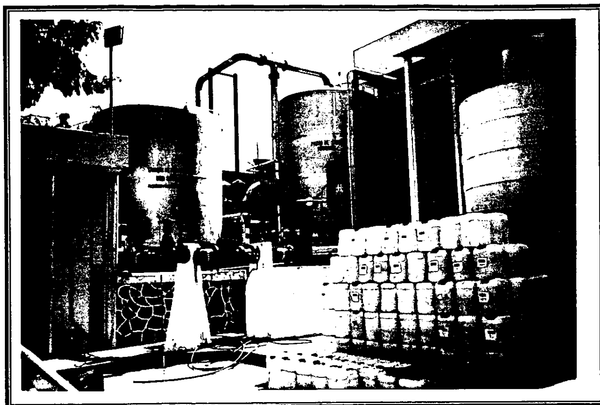
FOTO I.3 Vista frontal de los reactores de ozonación y de carbón activado biológico. En esta foto también se aprecian los bidones de solución de HCl, que se utiliza en el lavado de membranas de EDR.
