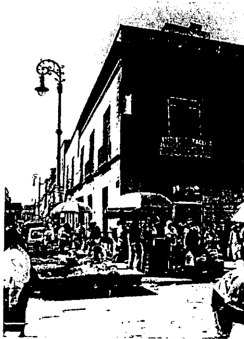
15. Esquina y finalización de calle Moneda (antigua Santa Inés) y Calle Academia (antigua Amor de Dios). Casa de Familia. Actualmente convertida en depósitos de mercaderías y locales comerciales (Foto: M.De Luca).
