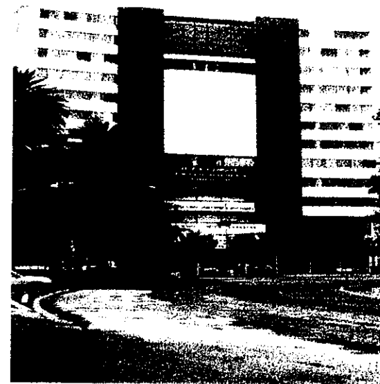
El cine Plaza delimita al Corredor Cultural (oeste)
