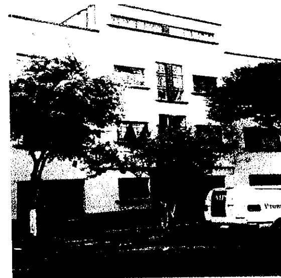
Se pretende reubicar el edificio de vivienda. Nótese el hundimiento del lado izquierdo
