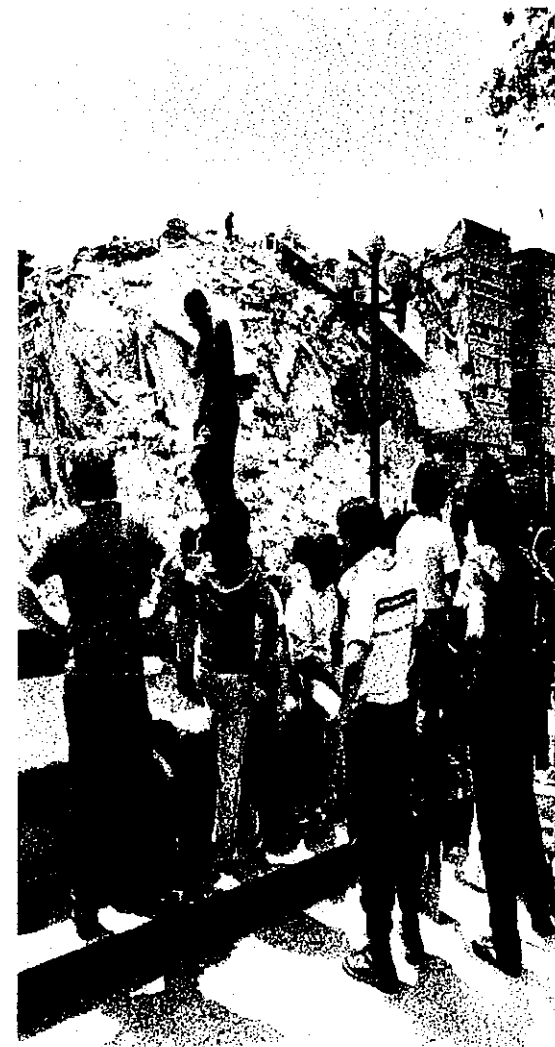
Los sismos de 1985 afectaron muchas de las construcciones que se encontraban en la Av. Alvaro Obregón
