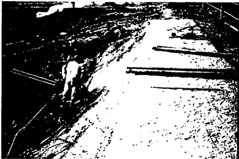
**Martillo neumático de fondo. Máquina perforadora neumática, que muestra sus múltiples aplicaciones, aquí empleándose en la colocación de anclas en la estabilización de taludes.**
