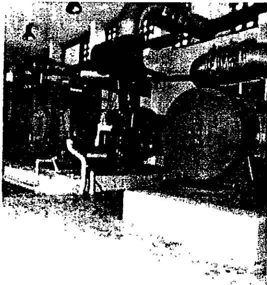
fig.4 La aereación se lleva acabo mediante aire comprimido
