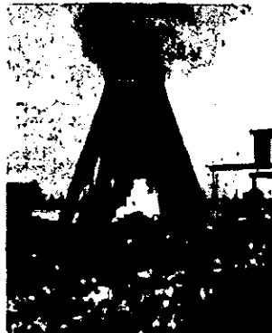
Del incinerador tipo "tepee" en Picayune, Misisipi, se eleva una columna de humo de unos 20 metros sobre el suelo. A pesar de ello, contamina el aire tanto como la incineración abierta, y se ha prohibido su uso.
