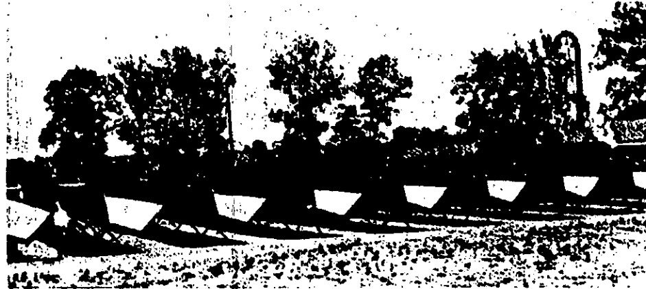
Vista general de la parte occidental de los colectores solares planos con espejos de refuerzo por Shuman en Tacony (Filadelfia) en 1911.
