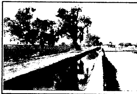
Fuente: Levantamiento en campo. Fig. 71.- Canal de irrigación proporcionando humedad al ambiente.
