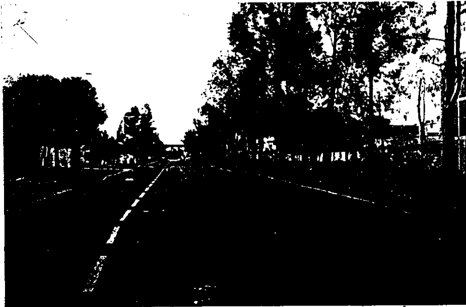
AVENIDA PUENTEROS VISTA SUR - NORTE
