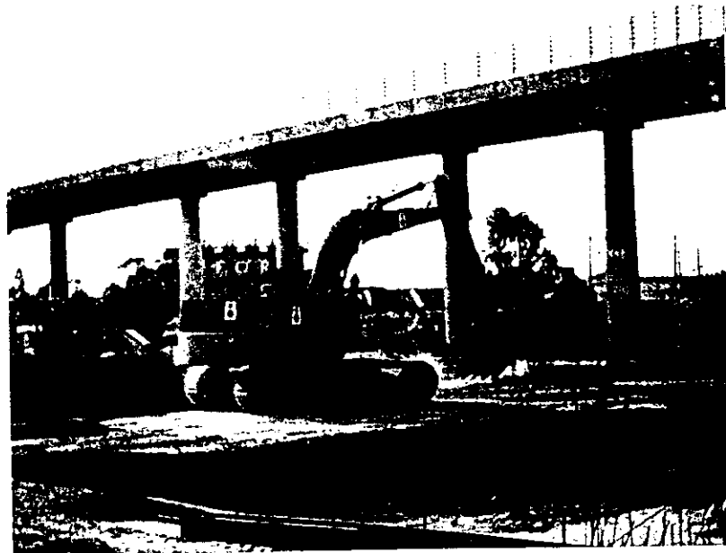
EQUIPO PARA EXCAVACION EN ZAPATAS
