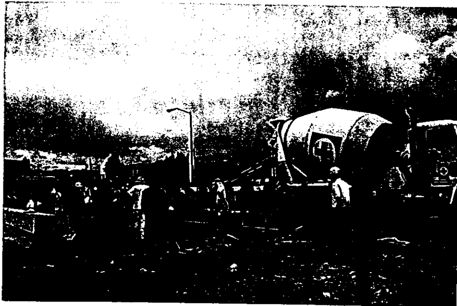
COLADO DE PILOTES
