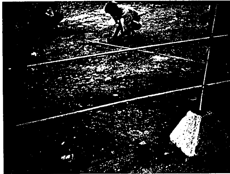
MARCADO DE LA UBICACIÓN DEL HINCADO DE PILOTES
