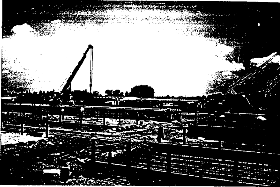
PLANTA PARA FABRICACIÓN DE PILOTES
