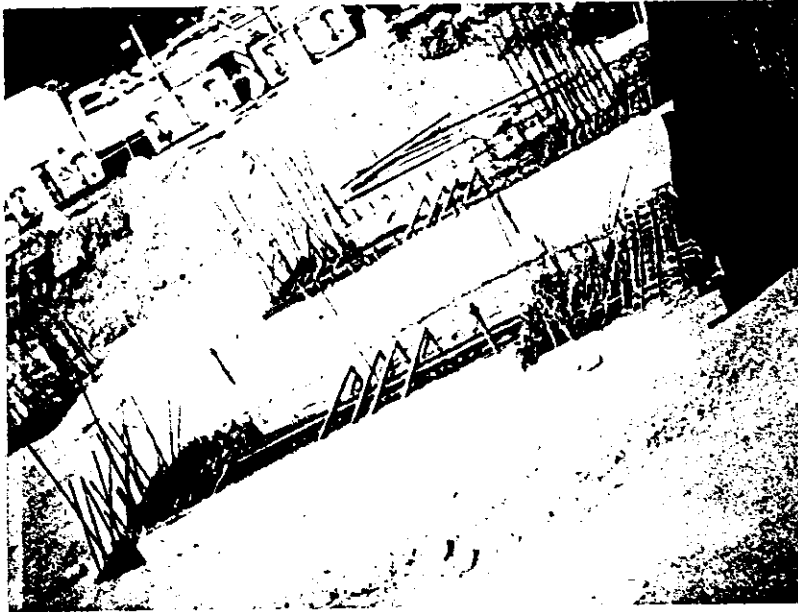
HUECO EN ZAPATA PARA LA COLOCACIÓN DE COLUMNAS
