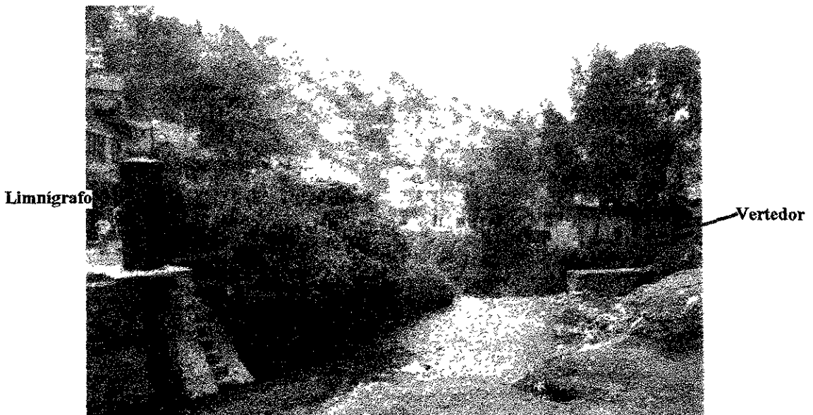
Fig. 2.11 Estación hidrométrica de la cuenca del río Mixcoac
