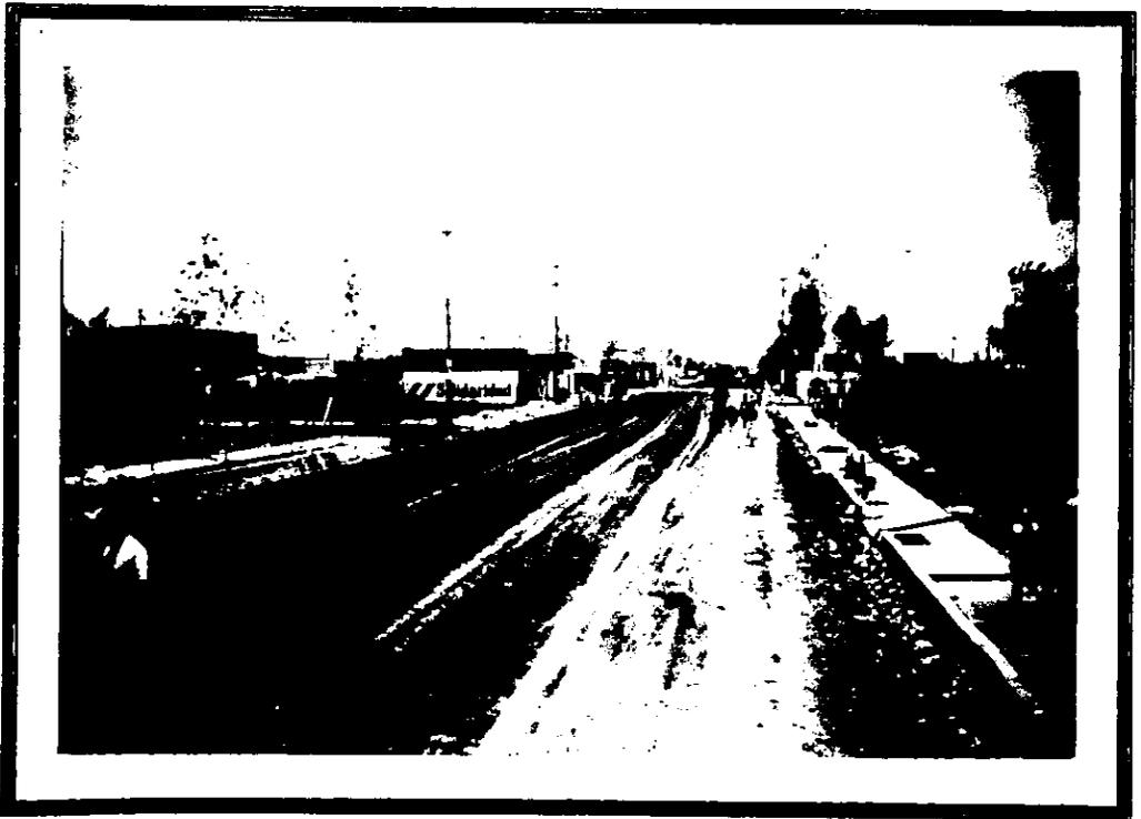
Vista 7 tendido de sub-base y base hidráulica
