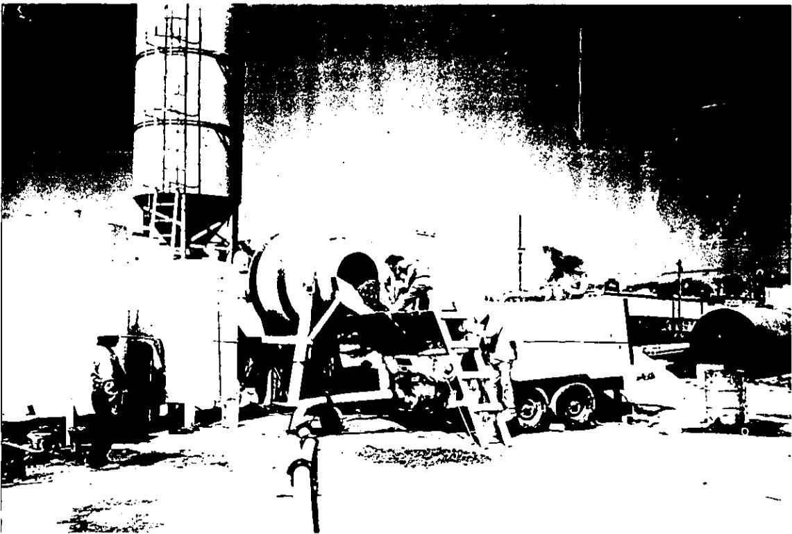
Foto No.42 Planta de concreto con equipo de bombeo, utilizada para el colado de los cabezales prefabricados.
