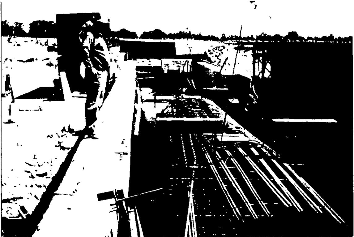
Foto No. 29 Introducción del armado del acero de refuerzo al molde, sin acero de presfuerzo.
