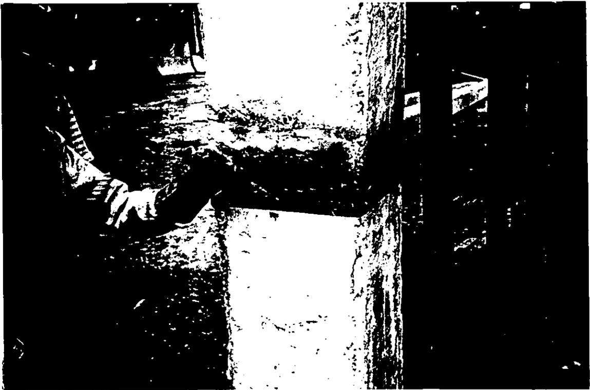
Foto No.16 Empalme de tramos de pilote por medio de placa de  $\frac{3}{4}$ " de espesor soldadas en todo su perimetro
