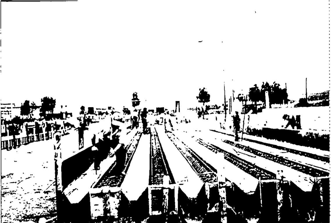
Foto No. 7 Colocación del armado de refuerzo, utilizando como cimbra los pilotes anteriormente colados.
