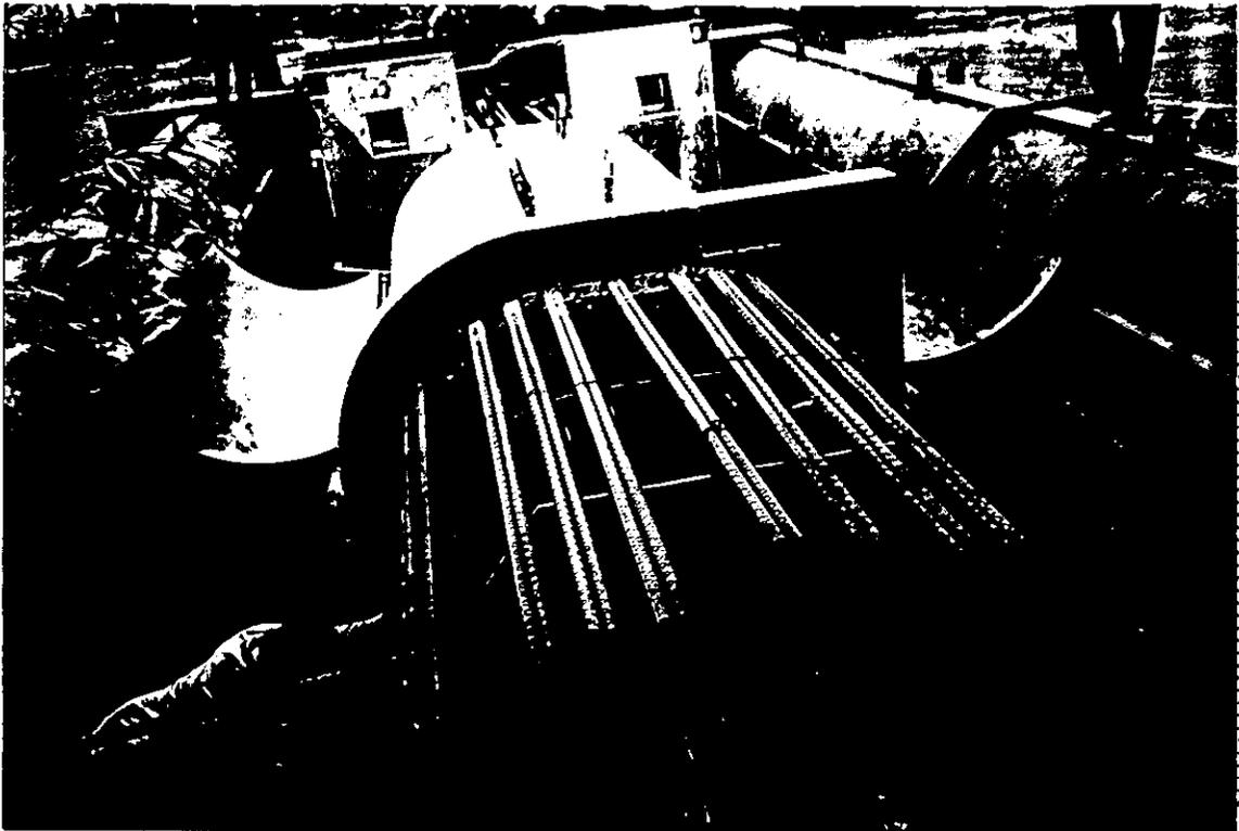
Foto No. 33 Destensado y descimbrado de la columna prefabricada alcanzada la resistencia del 80% de proyecto
