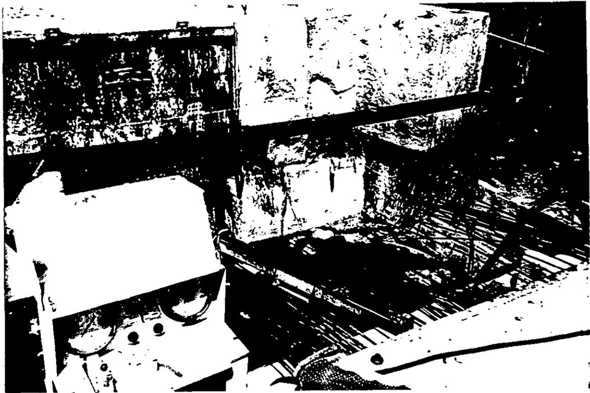
Foto No. 55 Momento del tensado de los cables de presfuerzo, utilizando gato hidráulico monotorón en traves presforzadas.
