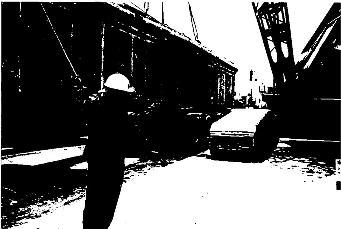
Foto No.46 Descarga del cabezal del equipo que lo transporta utilizando l grúa de 140 tons. En el terreno de almacenamiento.
