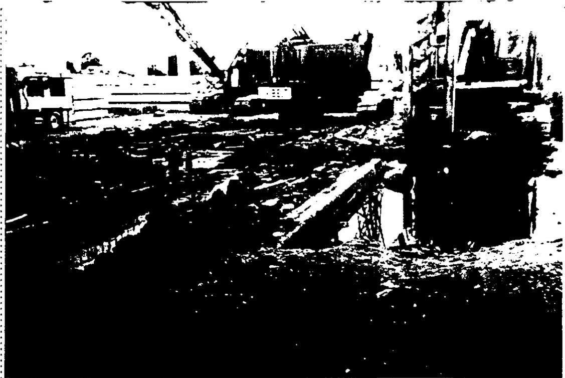
Foto No. 13 Equipo utilizado para la perforación para el hincado de pilotes de sección 40 x 40 cm.
