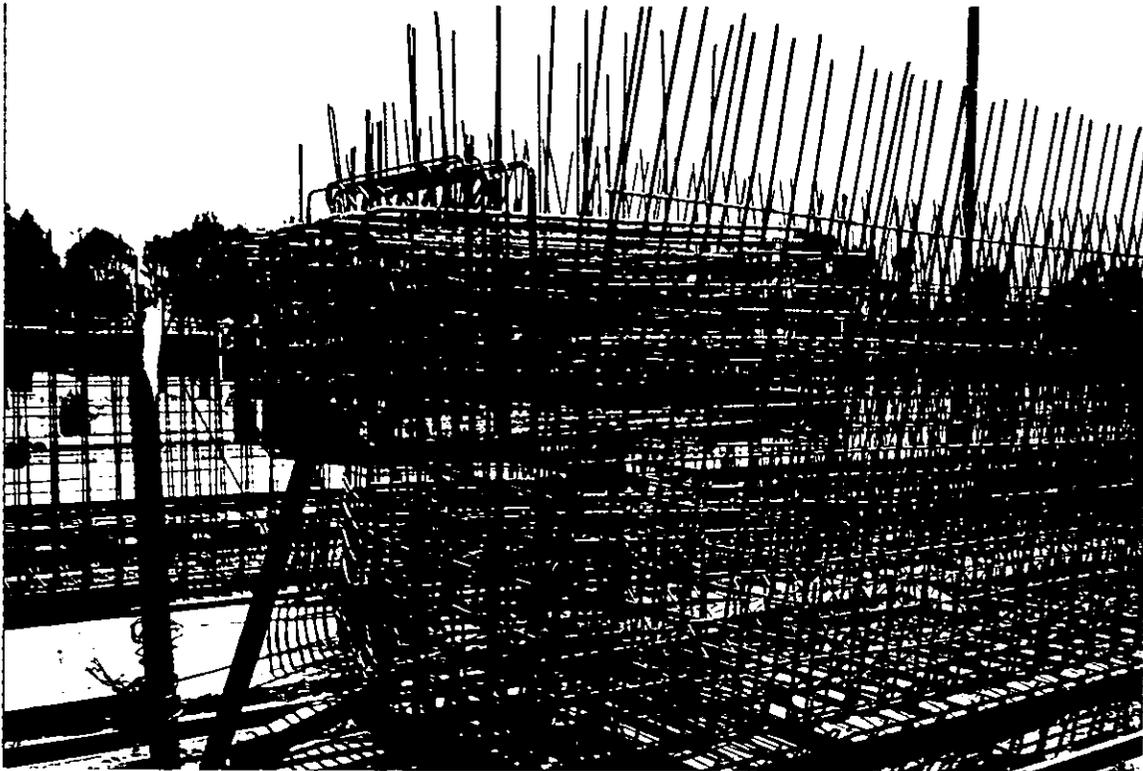
Foto No. 51 Armado del acero de refuerzo con accesorio para ménsula de trabe central (TC) con peralte de 2.00m.
