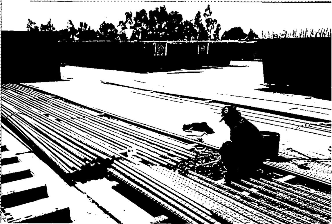
Foto No. 49 Habilitado del acero de refuerzo para la fabricación de las traves centrales (TC) presforzadas.
