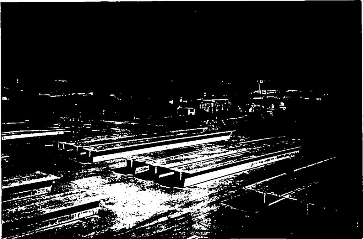
Foto No.64 Almacenamiento de las traves centrales (TC) con peralte de 2.00 m en planta de prefabricados, sobre un terreno mejorado.
