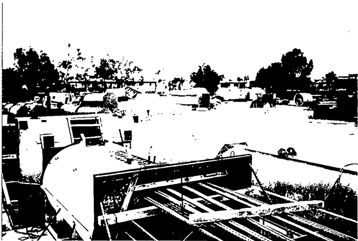
Foto No.30 Acero de presfuerzo tensado, accesorios y preparaciones antes del colado de la columna prefabricada.
