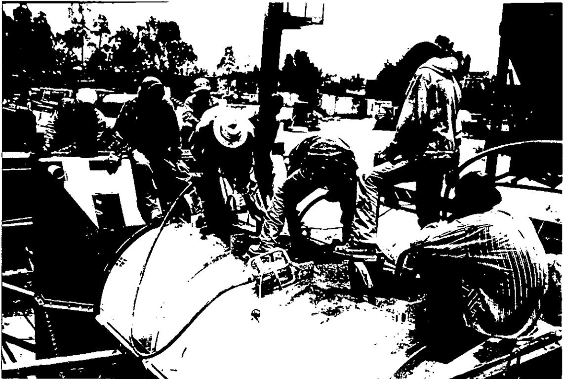
Foto No. 31 Colado de columna prefabricada. utilizando 3 vibradores.
