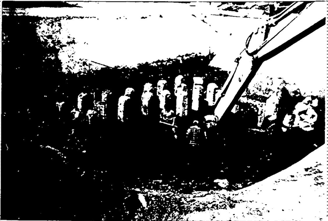
**Foto No. 18** Excavación del cajón de cimentación a cielo abierto al fondo se puede apreciar el sistema de protección temporal.
