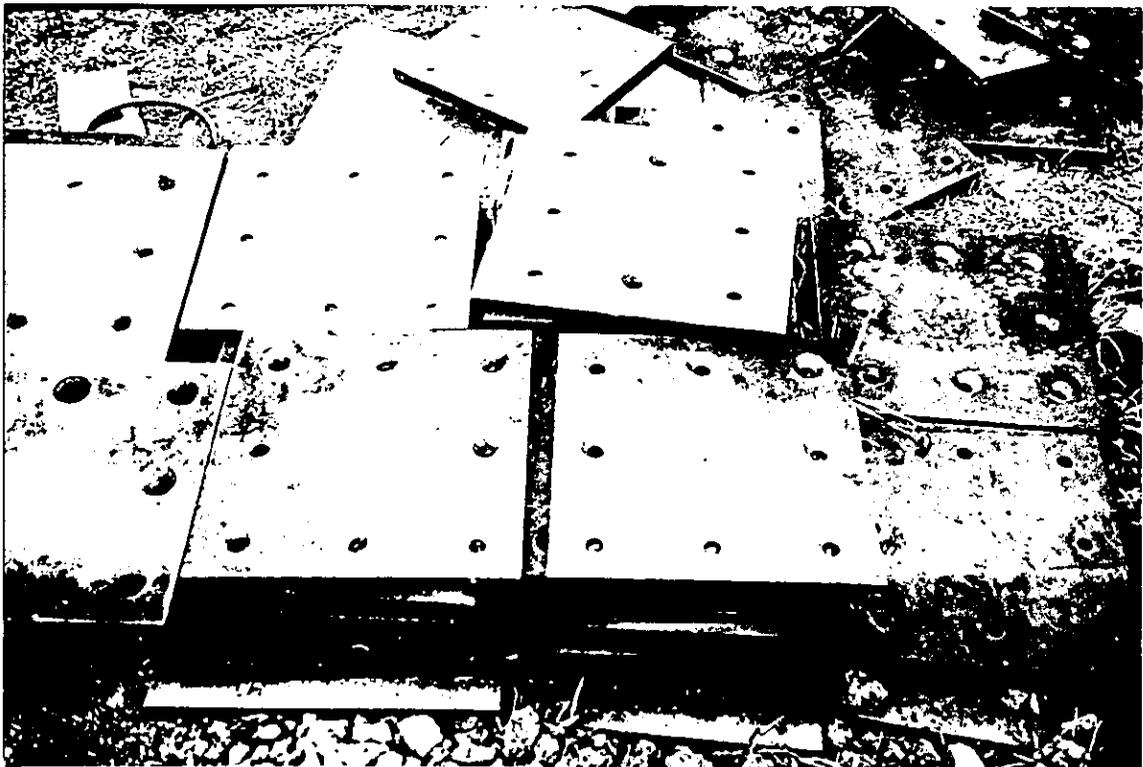
Foto No. 2 Habilitado de placa de  $\frac{3}{4}$ " de espesor de 40 x 40 cm para el accesorio de pilotes. (utilizado para unir los tramos de pilote).
