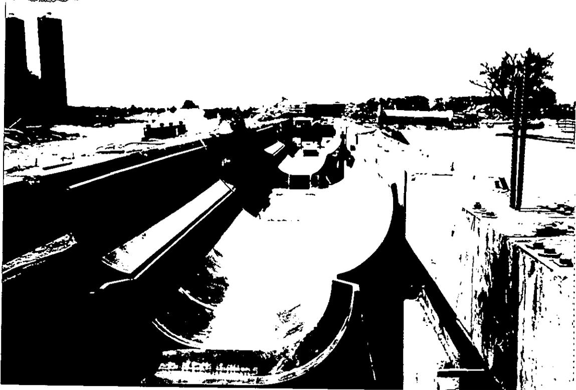
Foto No. 25 Mesas de trabajo de concreto reforzado y cimbra metálica abatible, para colado de columnas de sección oblonga de 1.50 x 2.00 m
