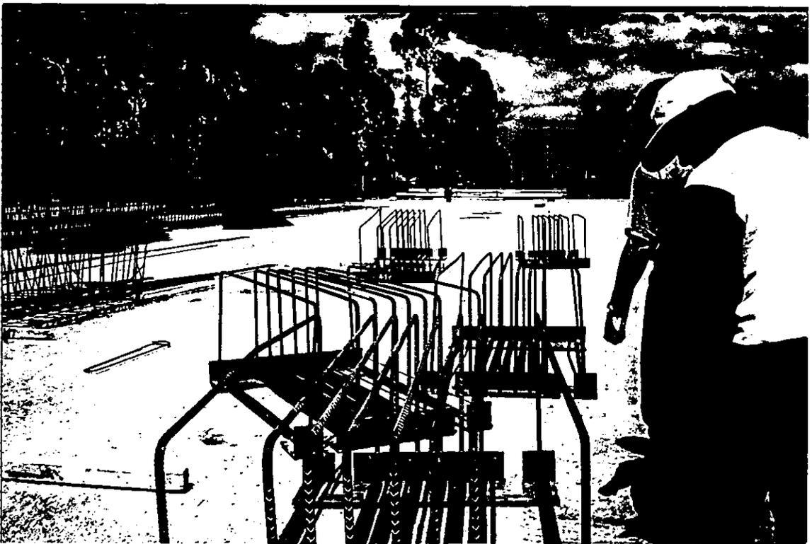
Foto No.50 Accesorios tipo para el armado de las mensuales de las traves centrales (TC) con peralte de 2.00 m
